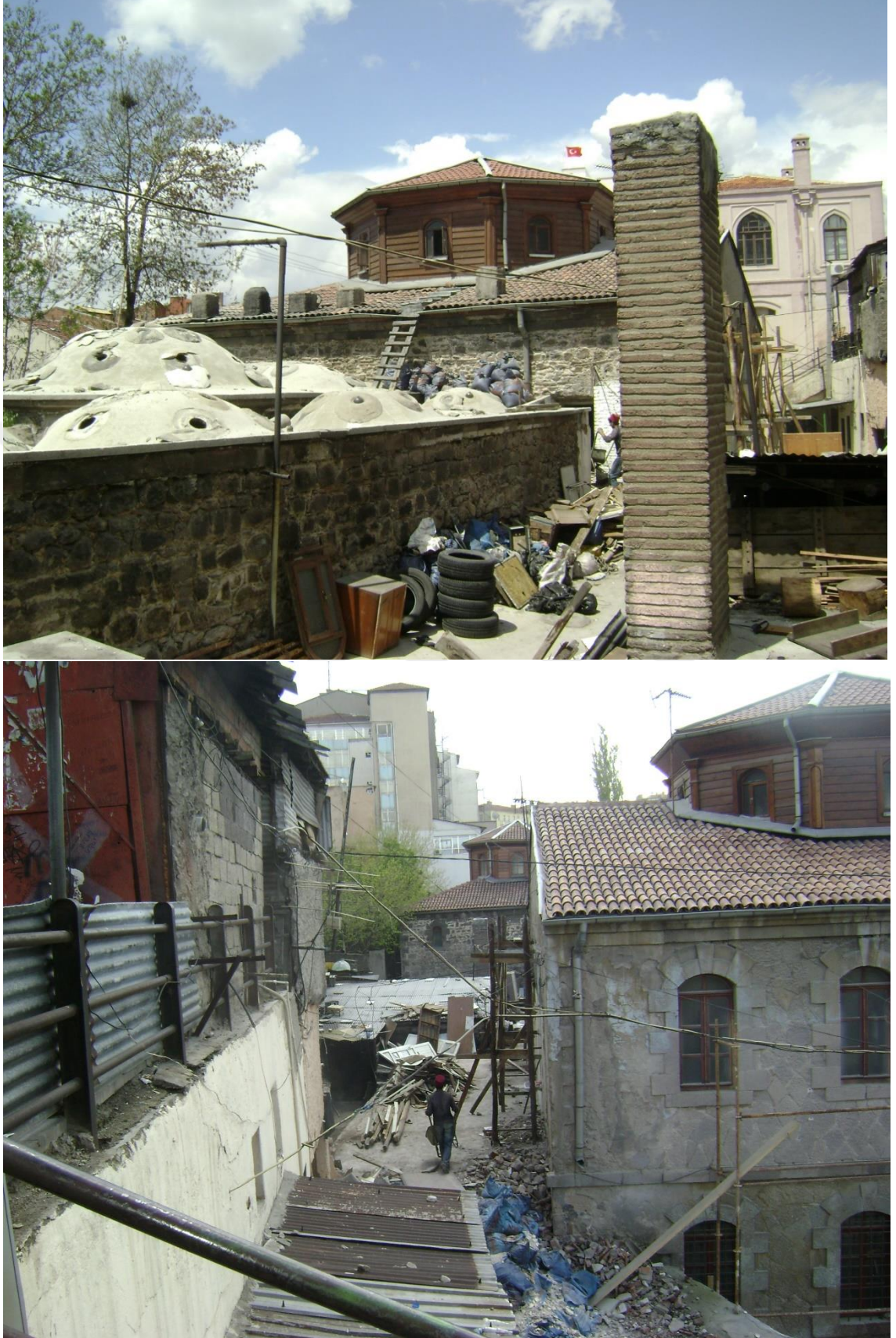
EK-26:Şengül Hamamı Restorasyon Aşaması-8-Kubbe Onarımı (Celalettin Aslan)
