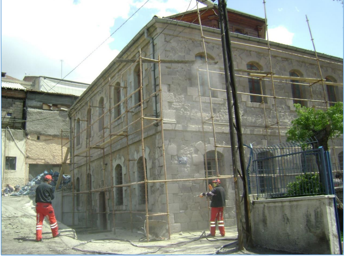
EK-19: Şengül Hamamı Restorasyon Aşaması 1 –Cephede temizlik (Celalettin Aslan)
