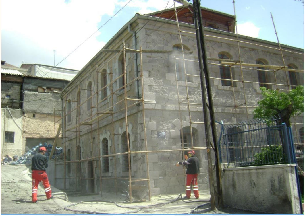
EK-14: Şengül Hamamı Erkekler Kısmı Restorasyon Esnası (Huriye Aslan)
