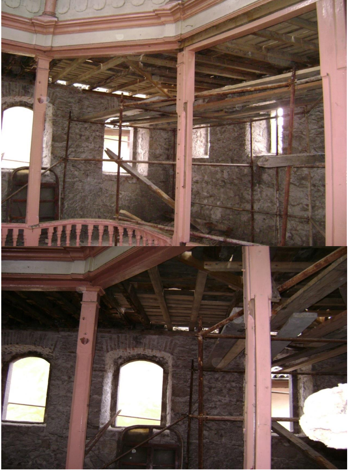
EK-24: Şengül Hamamı Restorasyon Aşaması-6-Soyunma Odalarında Yenileme (Celalettin Aslan)
