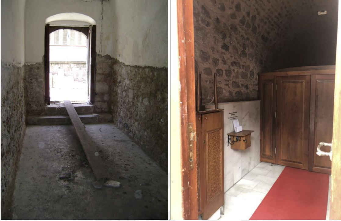
EK-15:Şengül Hamamı Kadınlar Kısmı Ilıklık Restorasyon Öncesi-Sonrası
