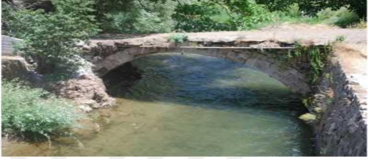
Şekil: 6. Kuşluk Köprüsü. 650
