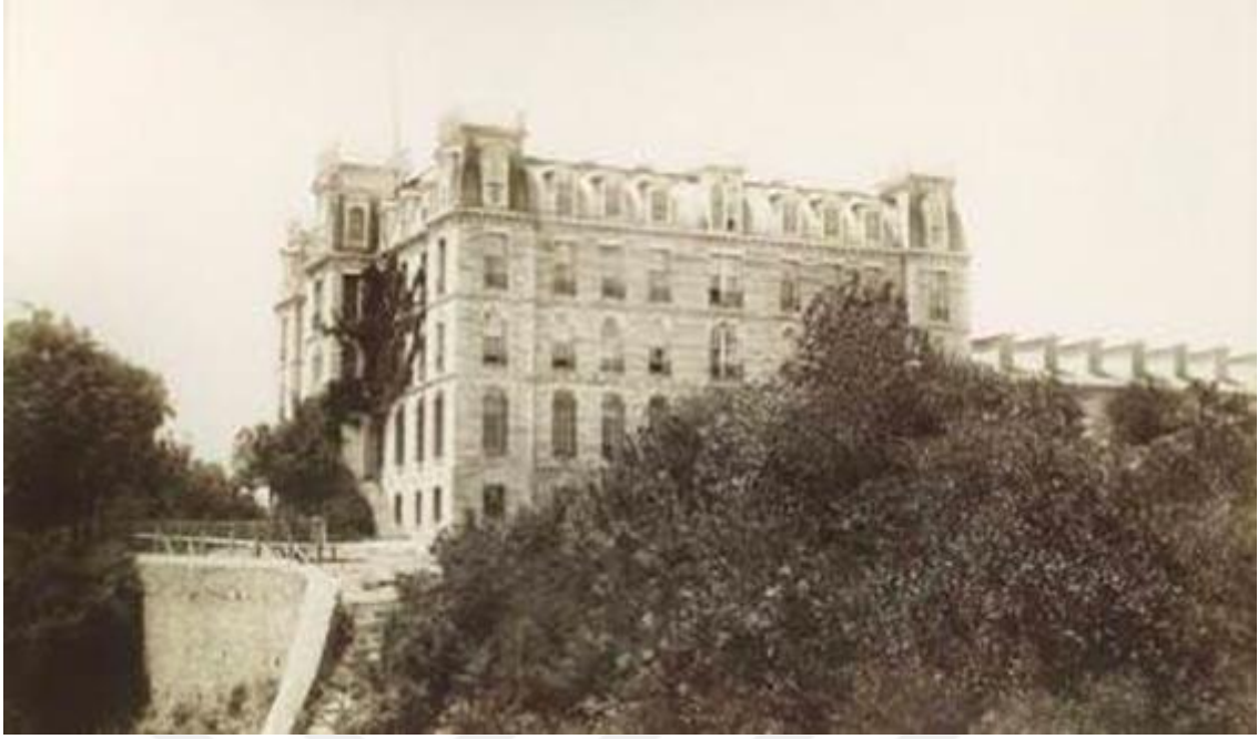
Robert Kolej Hamlin Hall Binası
