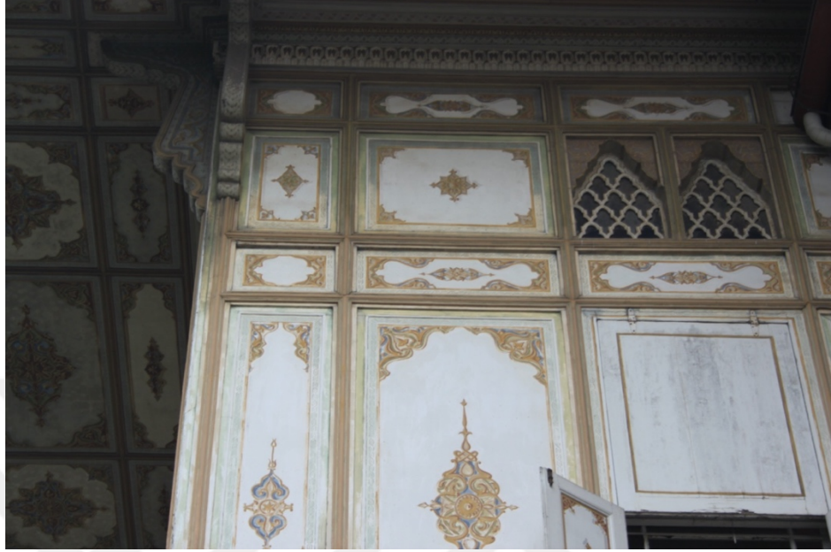
Şekil 3.14. Revzenli tepe pencereleri.
