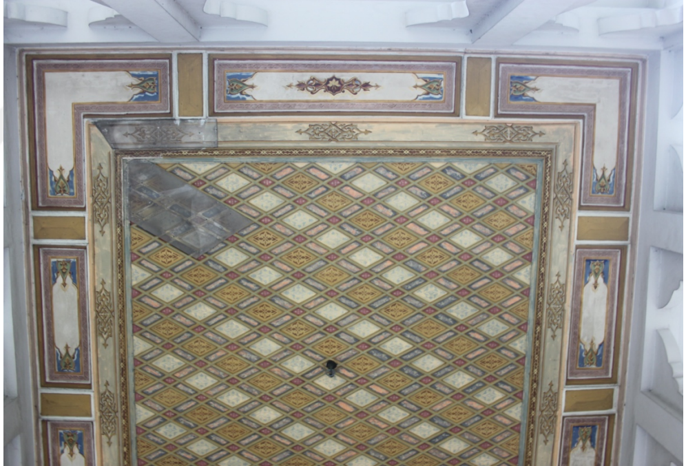
Şekil 3.27. Batı cephesindeki girişin tavanı.
