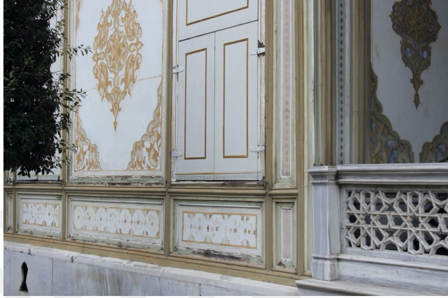
Şekil 3.3. Mermer şebekeler ve dikdörtgen kaset sırası.
