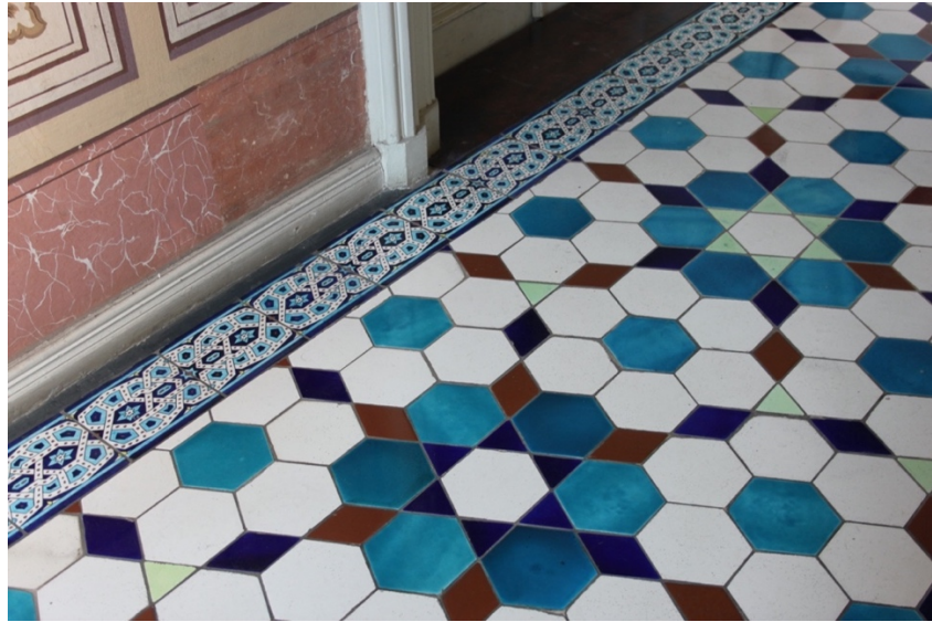
Şekil 3.41. Yer döşemesi ve yalancı mermer kalemişleri.
