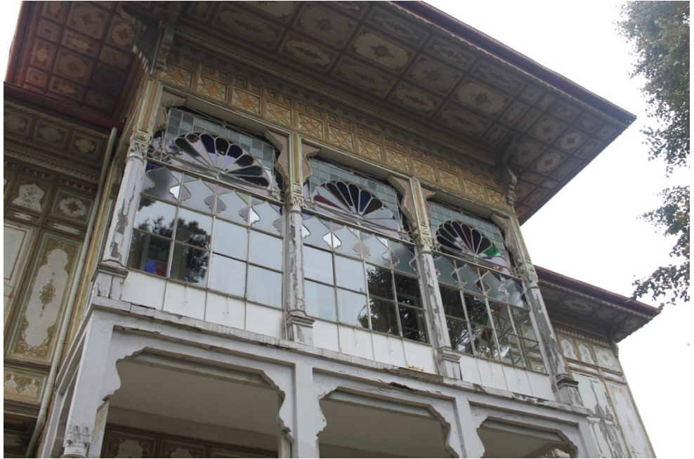
Şekil 3.32. Kuzey cephesindeki revzenli çıkma.
