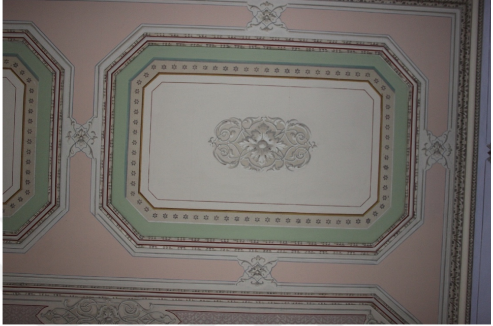
Şekil 3.39. Merdivenli bölümün tavan işlemesi.
