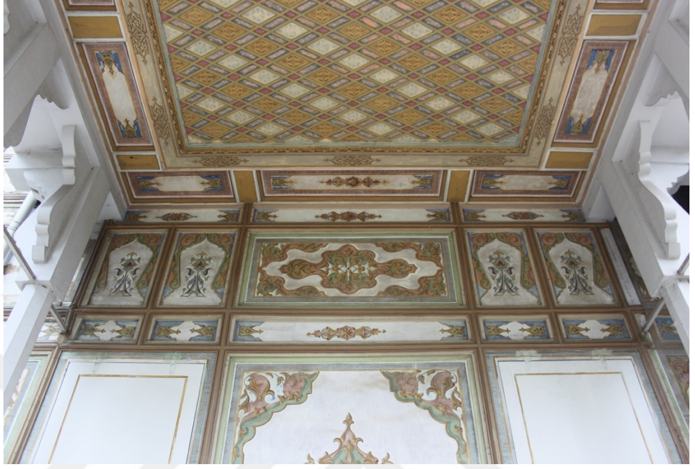
Şekil 3.28. Batı cephesindeki çıkmadaki desenler.
