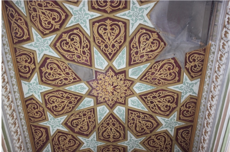
Şekil 3.29. Doğu cephesi tavanı.
