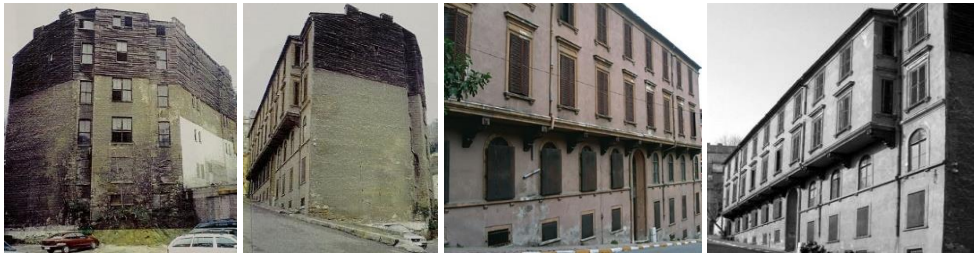
Şekil 26. Restorasyon öncesine ait cephe görüntüleri (MArS-Mimarlar Arşivi)
