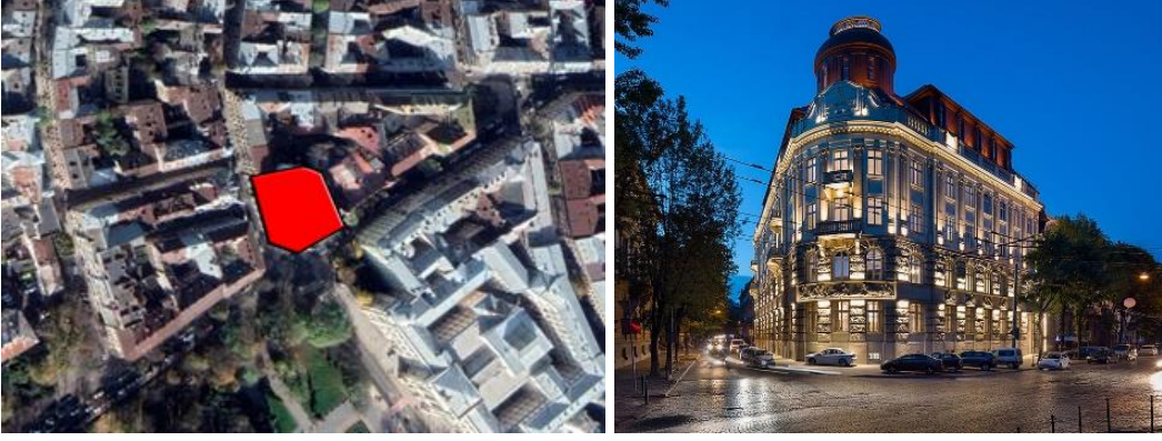
Şekil 6. Bank Otel konumu ve cephe görünümü (URL-3)
