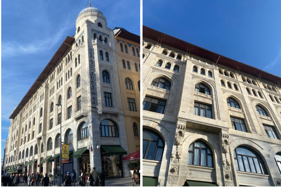
Şekil 34. Legacy Ottoman Hotel cephe görünümü (Kişisel fotoğraf arşivi, 2024)
