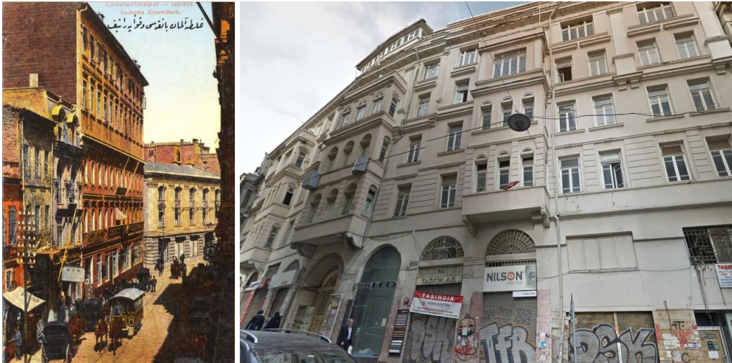
Şekil 33. Yapının bulunduğu Bankalar Caddesi 19.yy sonları görünümü ve restorasyon öncesine ait cephe görünümü (URL-17, URL-18)
