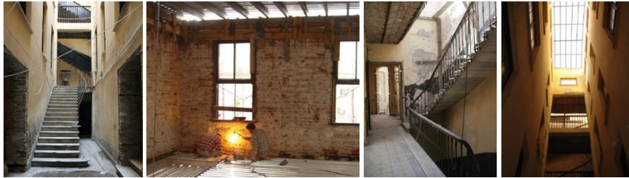
Şekil 27. Restorasyon öncesine ait iç mekan görüntüleri (URL-14)
