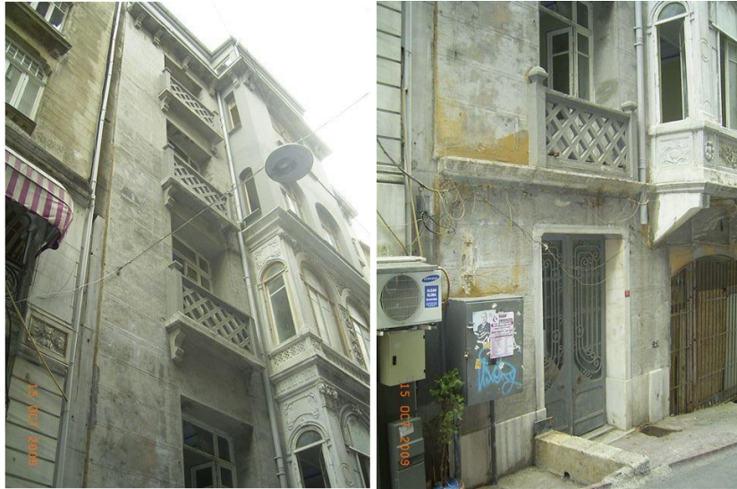
Şekil 29. Restorasyon öncesine ait cephe görünümleri (Tever, 2013)
