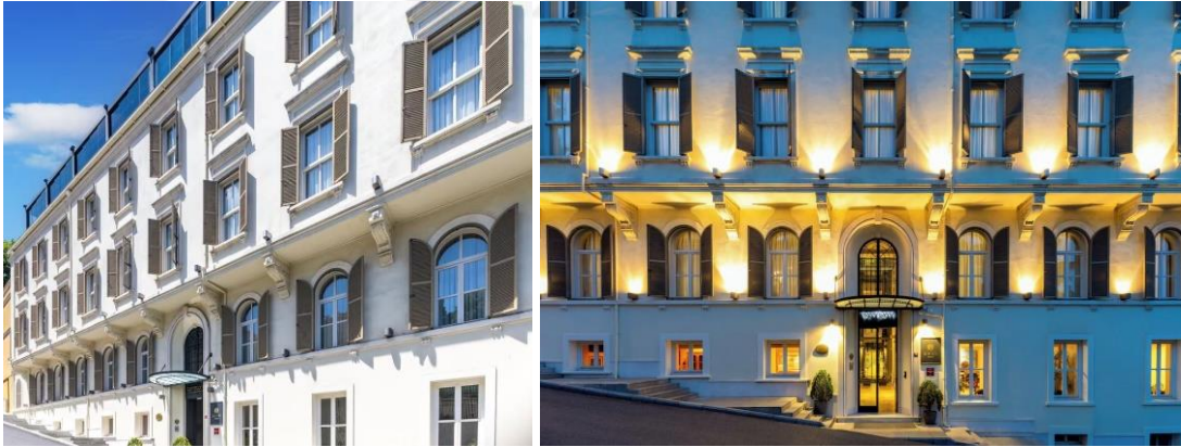
Şekil 41. Tomtom Suites cephe görünümü (URL-20)
