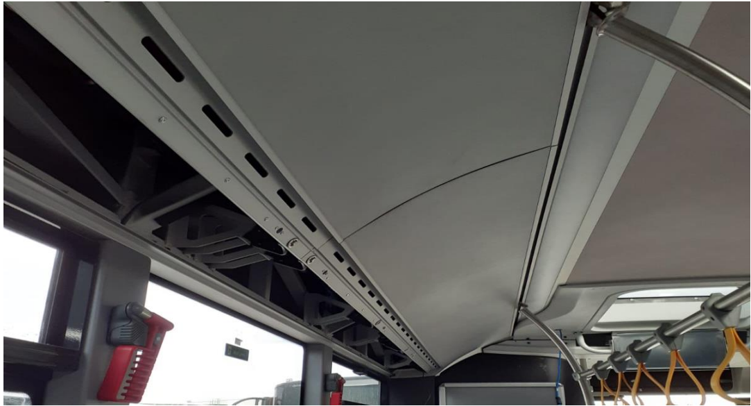
Şekil 4.13. Hava kanalının otobüs tavana montajı
