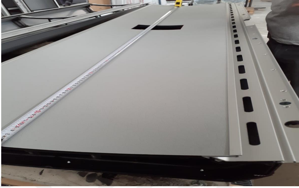
Şekil 4.12. Hava kanalı montajı
