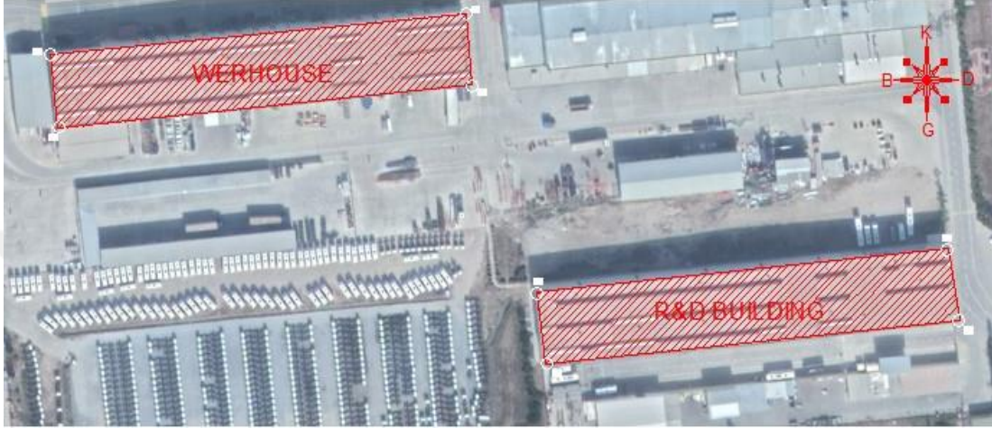
Şekil 4.2. Güneş paneline uygun tesis çatıları
