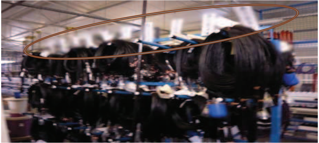
Şekil 4.12. Kablo tesisatı askı üniteleri iyileştirme sonrası durum.
