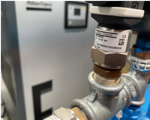
Şekil 27 Basınç Sensörü
