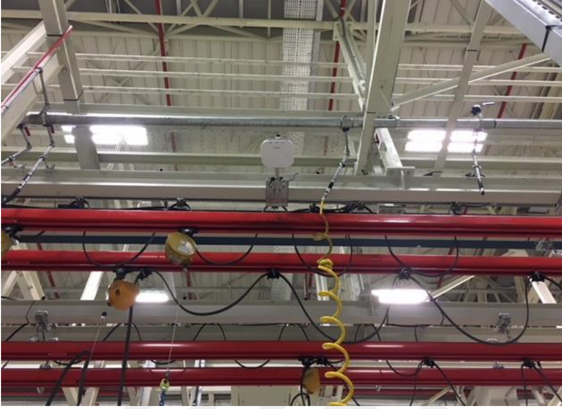
Resim 3.7 İstasyonu Kapsayacak Şekilde Monte Edilmiş RTLS Anteni
