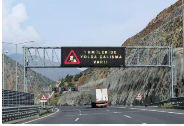
Şekil 2.11. Yol DMP Uygulaması [10]
