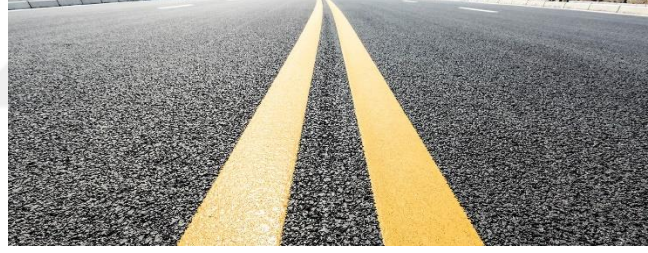
Şekil 2.17. Termoplastik Boya ile Trafik Belirteç İzleri [10]
