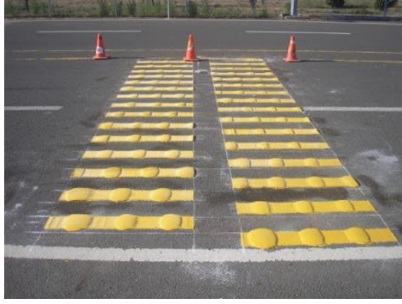
Şekil 2.16. Çift Komponentli Boya ile Trafik Belirteç İzleri [10]
