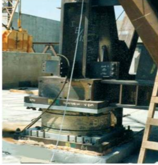
Şekil 3.6 Çelik kolon altına yerleştirilmiş izolatörler [33]
