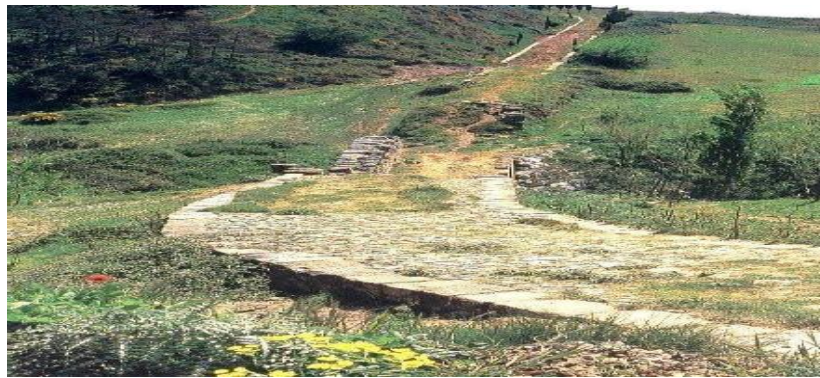
Şekil 2-3: Kuzey İspanya'daki Cirauqui Yakınlarındaki Hayatta Kalan Roma Yolunun Bir Kısım [5]
