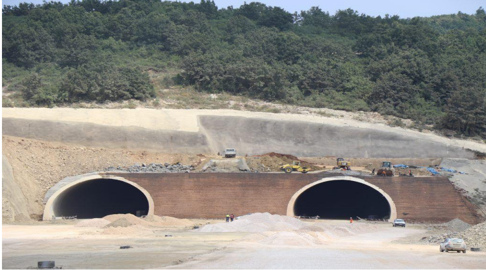
Şekil 4-23: Çatalca T1 ve T2 Tünelleri Yapım Çalışması [116]
