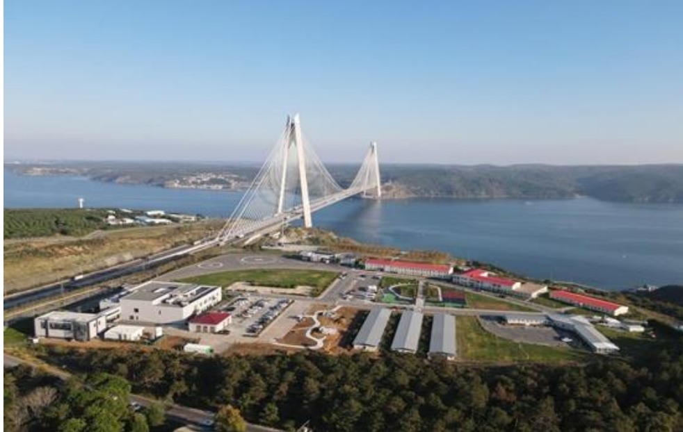
Şekil 4-36: Kuzey Marmara Otoyolu Ana Kontrol Merkezi Yerleşkesi [125]
