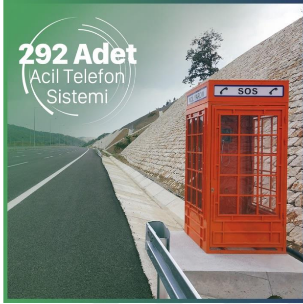
Şekil 4-35: Otoyol Acil Durum Telefonu [124]
