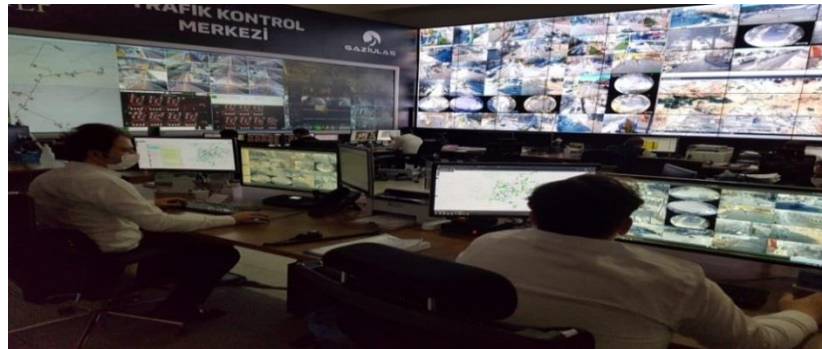
Şekil 3-7: Gaziantep Trafik Kontrol Merkezi [46]
