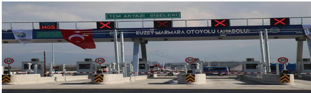
Şekil 4- 28: Kuzey Marmara Otoyolu Akyazı Ücret Ödeme Noktası (Sakarya) [128]
