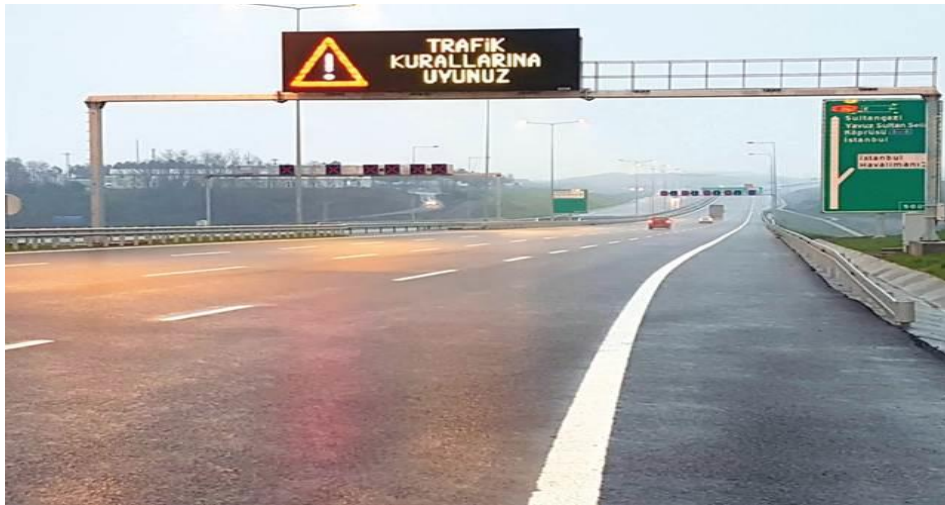
Şekil 4-30: Kuzey Marmara Otoyolu Değişken Mesaj İşareti [130]
