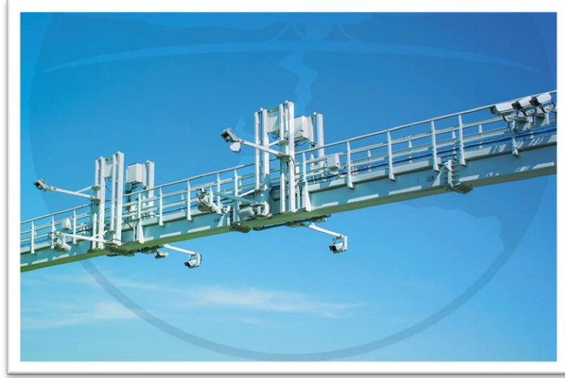
Şekil 4-34: Trafik Sayım Sensörleri-Hareketli ve Sabit AUS Kameraları [124]
