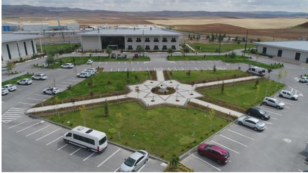
Şekil 4-18: Ana Kontrol Merkezi Yerleşkesi [107]
