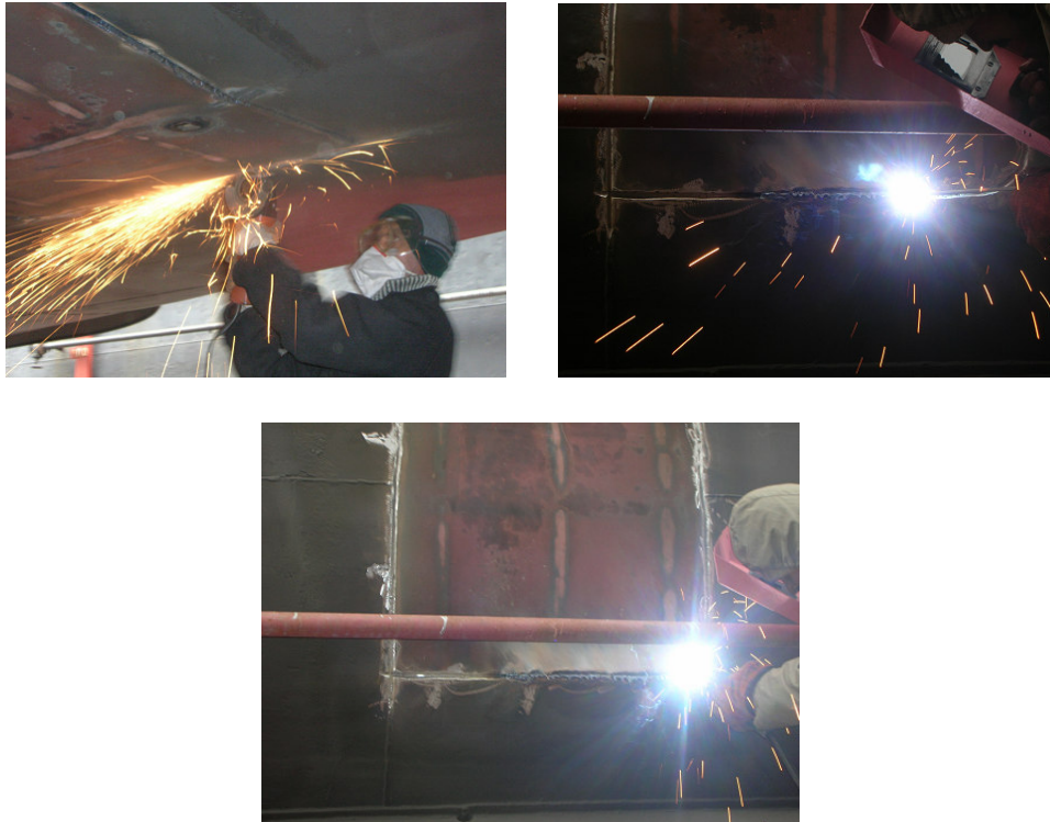
Şekil 6.16 Sacların kaynakla birleştirilme işlemleri
