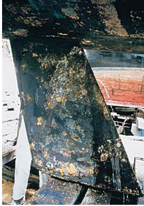
Şekil 2.7 Gemi uskurunda görülen çukurcuk korozyonu [11]
