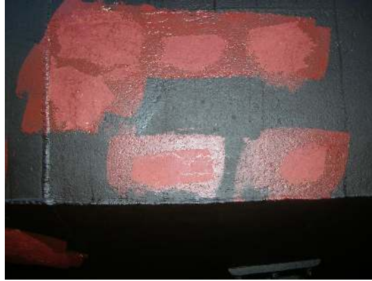
Şekil 6.11 Gemi teknesine yapılan çelik macun uygulaması
