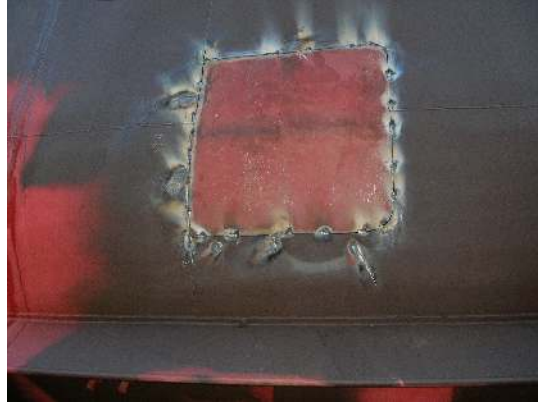
Şekil 6.12 Kalınlığı limit değerin altına düşen sacın kesilerek yenilenmesi
