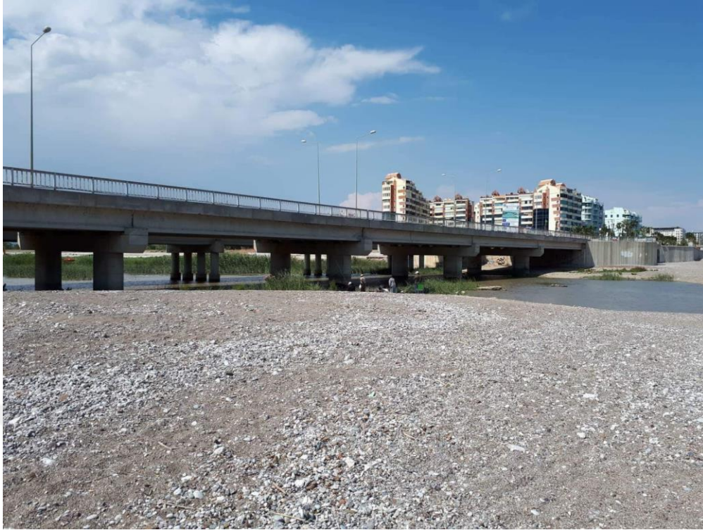
Şekil 3.2. Köprü genel görünüşü
