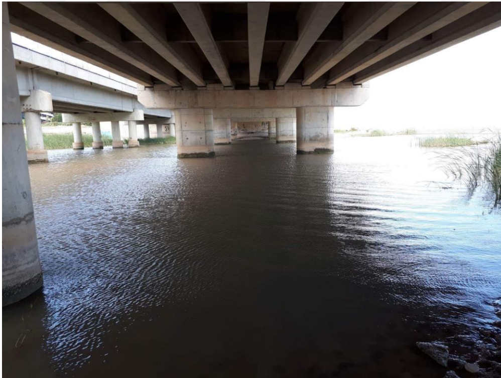
Şekil 3.3. Köprü ana elemanlarına ait bir görünüş
