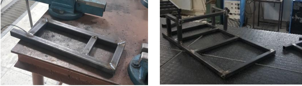
Şekil 4.24 KA şasi parçalarının imalatı.
