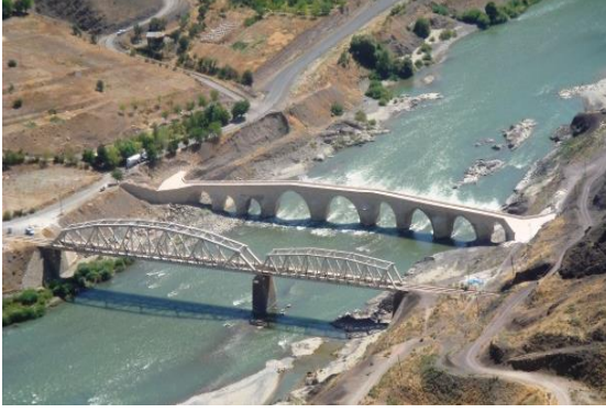
Foto 16: Restorasyon Sonrası Eski Palu Köprüsü
