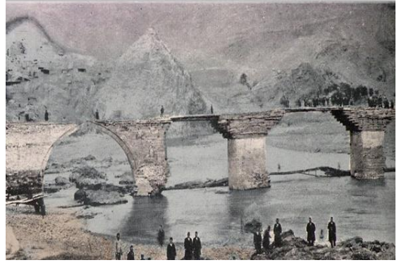
Foto 17: Palu Köprüsünün Eski Hali
