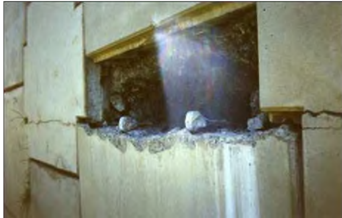
řekil 56. Cruflu toprakarme dolgusundan kaynaklı deformasyon (Smith, 2003)
