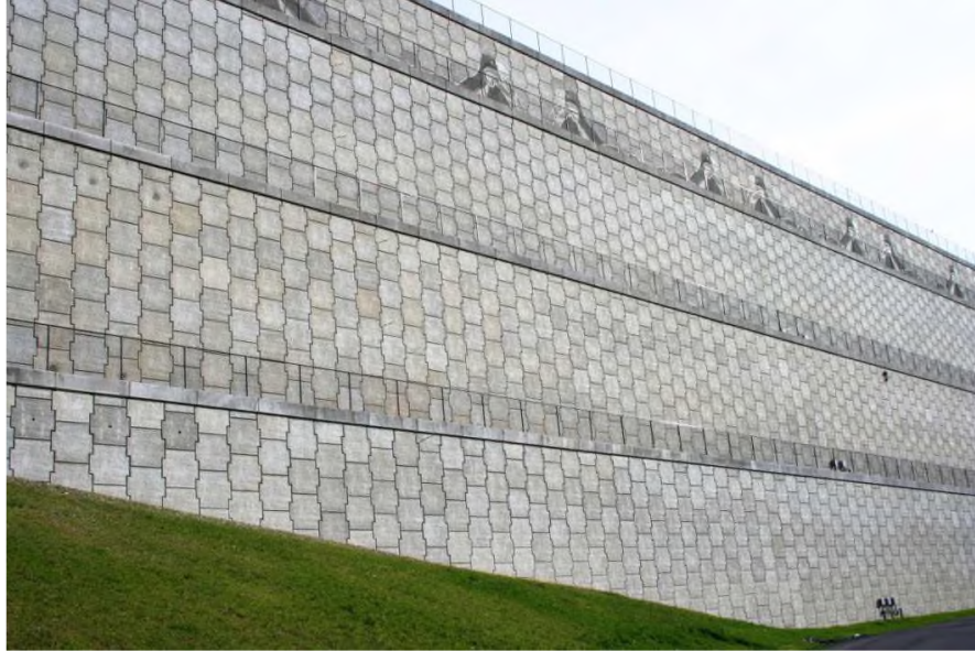
Şekil 59. Palyeli duvar uygulaması (Seattle Airport, RECO, 2003)
