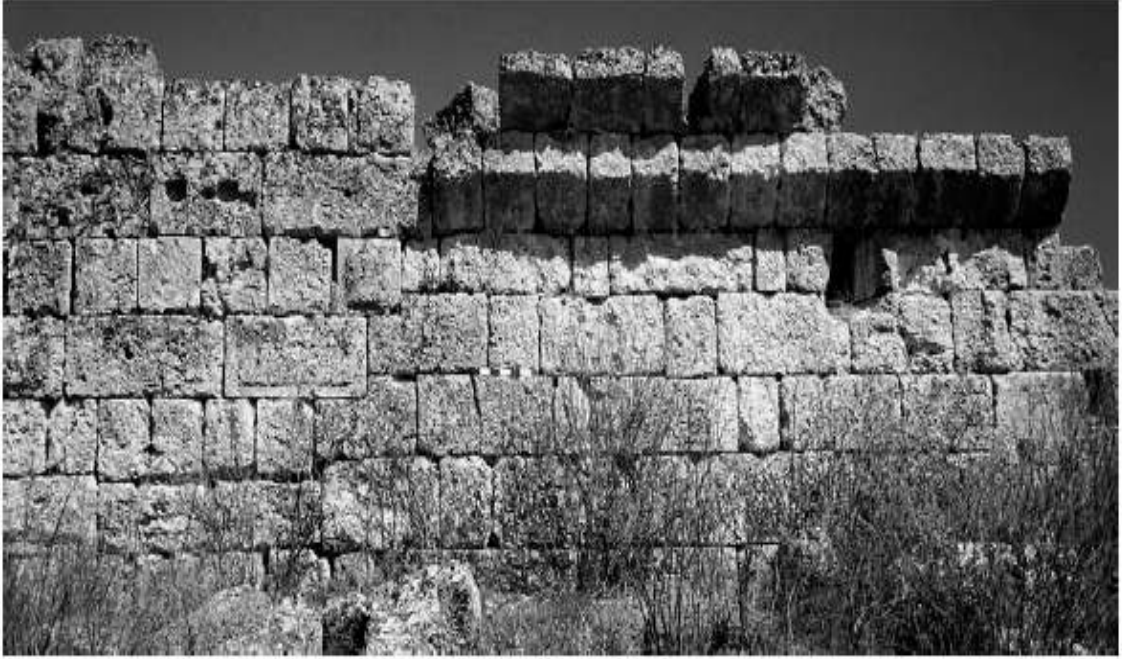
Resim 21: Doğu Surlarda Düz ve Konsol Kornişli Sur Duvarı
