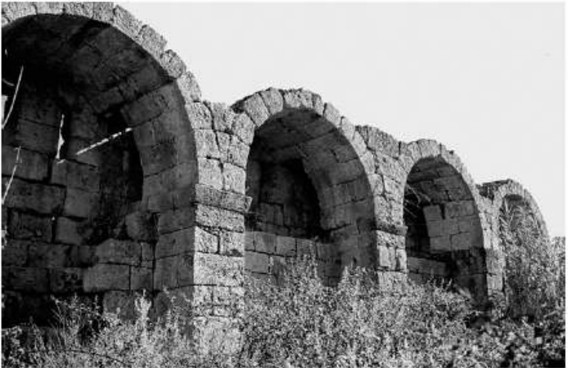
Resim 22: Güney Surlarda Kazematlı Sur Duvarı
