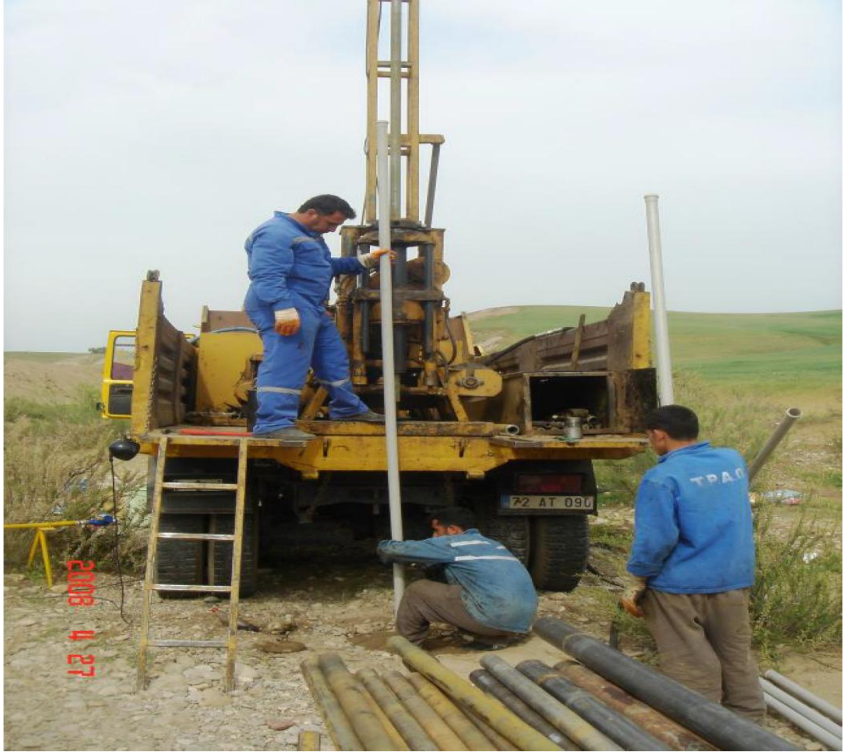
Şekil 3.1: Temel Sondaj Çalışmaları (DSİ ES Proje,2009)
