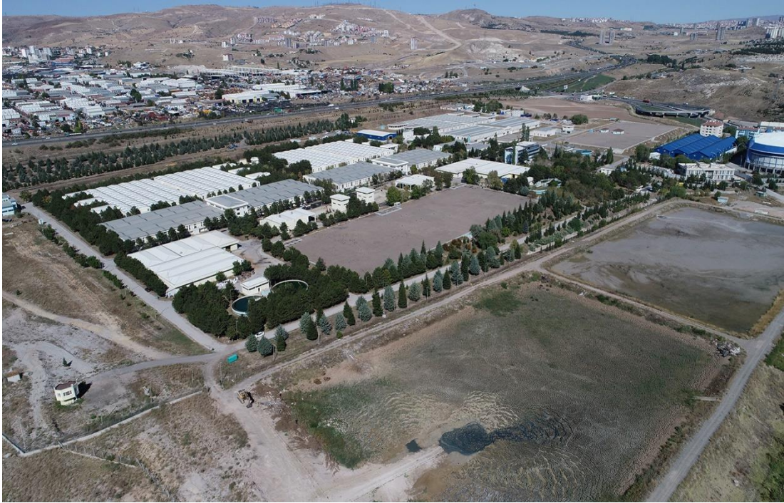
Şekil 3.1. İvedik Su Arıtma Tesisi
