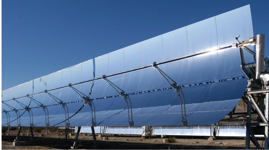
Şekil 3.14. Parabolik oluklu güneş kolektörü (German Aerospace Center, 2022)
