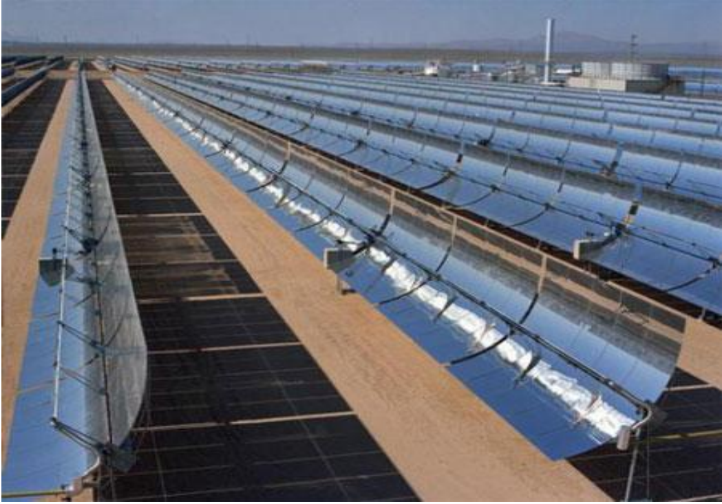
Şekil 4.3. Parabolik oluklu güneş enerjisi santrali [57]
