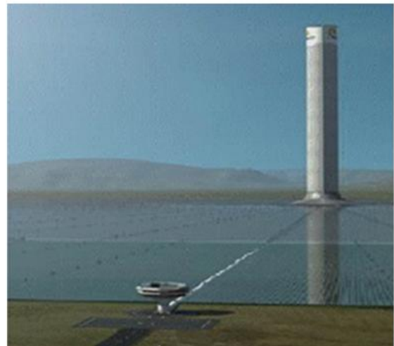
Şekil 3.10. Güneş bacaları çalışma prensibi, 200 MW'lık güneş bacası santrali, Avustralya
