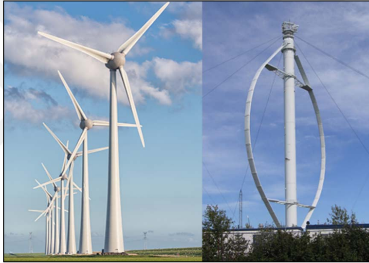
Şekil 4.2 Yatay eksenli rüzgâr türbini (sol) ve dikey eksenli rüzgâr türbini (sağ) (Peco, 2021)
