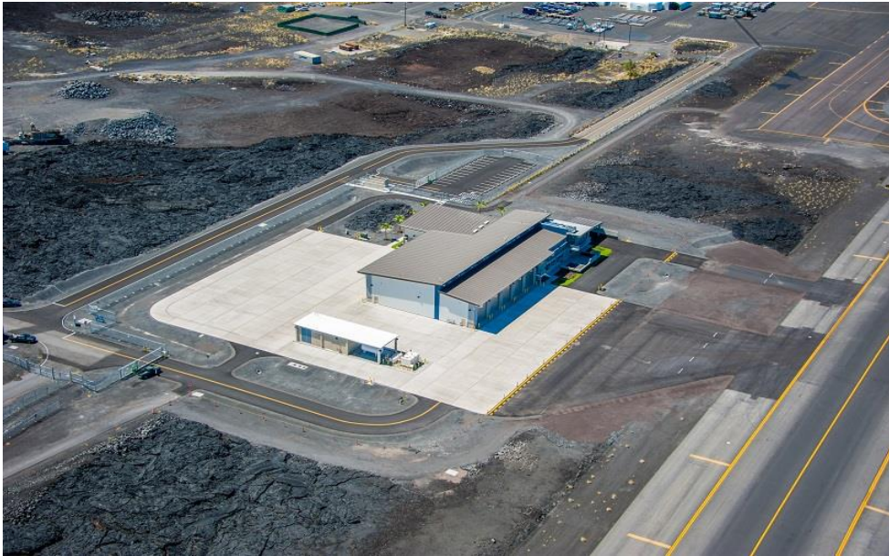
Şekil 2.2. Hava alanı yangın ekip binası [14].
