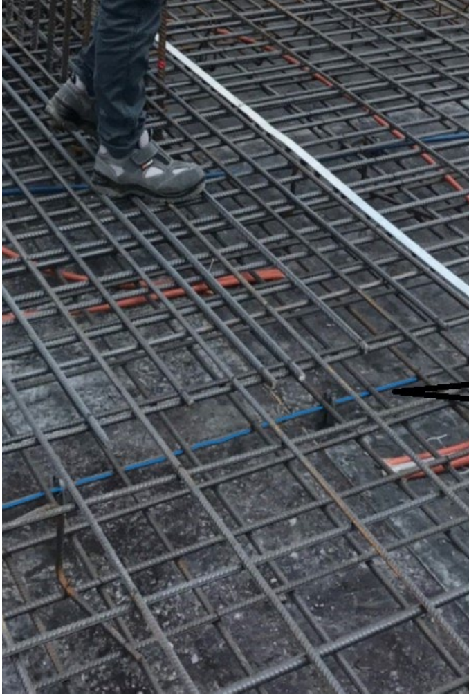
Şekil 3. Döşemede yardımcı olarak kullanılan şablon donatısı
