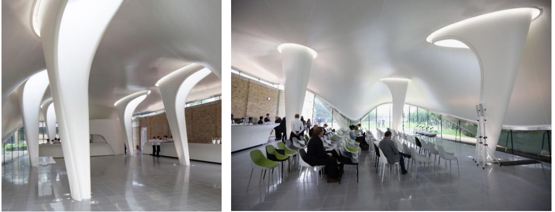
Şekil 46. Serpentine Sackler Galerisi'ne ait eğrisel sütunların membran çatıyla birleşimi.
