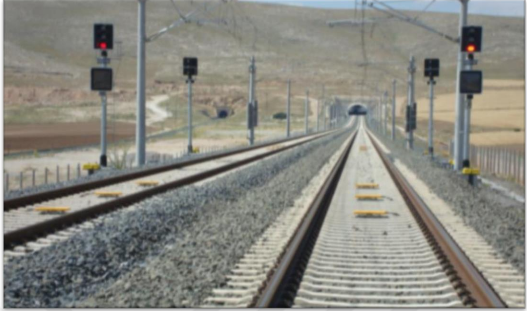
Şekil 2. 7. Demiryolu güzergahında balastın konumu
