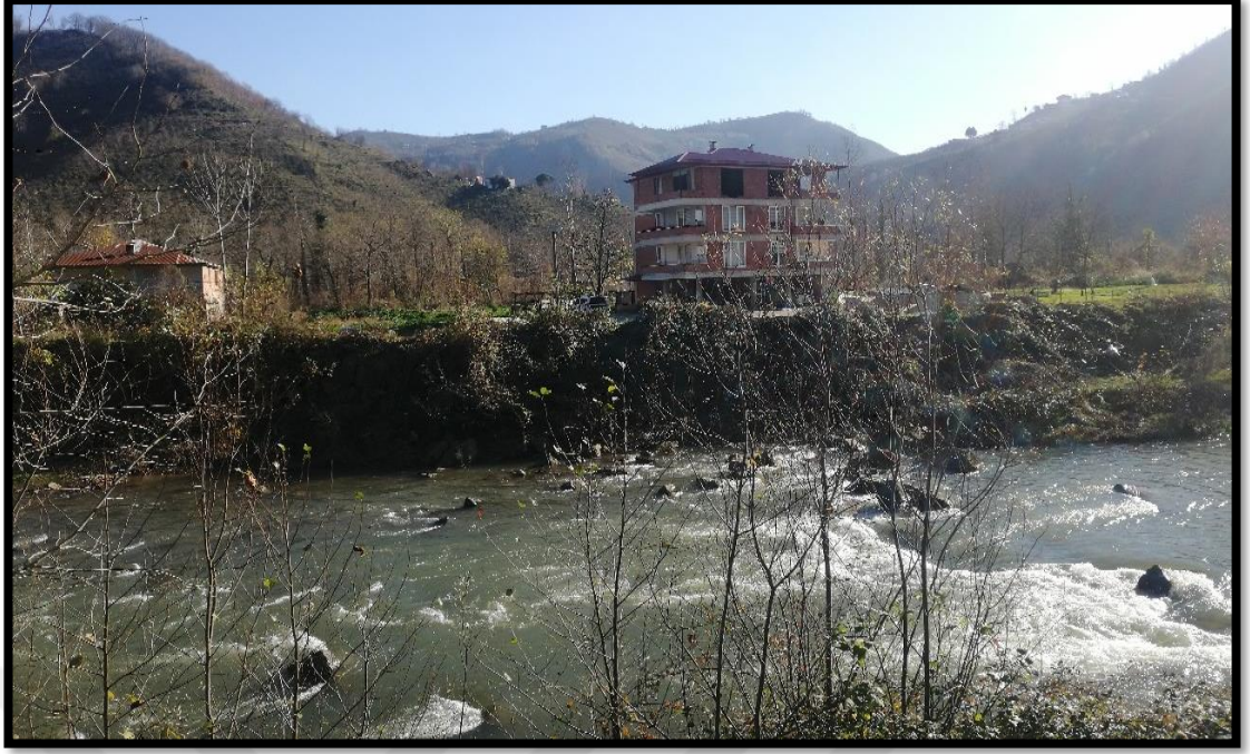
Şekil 5. 24 Pazarsuyu Köyü'nün güneyinde, akarsuyun batı yamacında dere yatağına yapılan yerleşme (1.01.2023)
