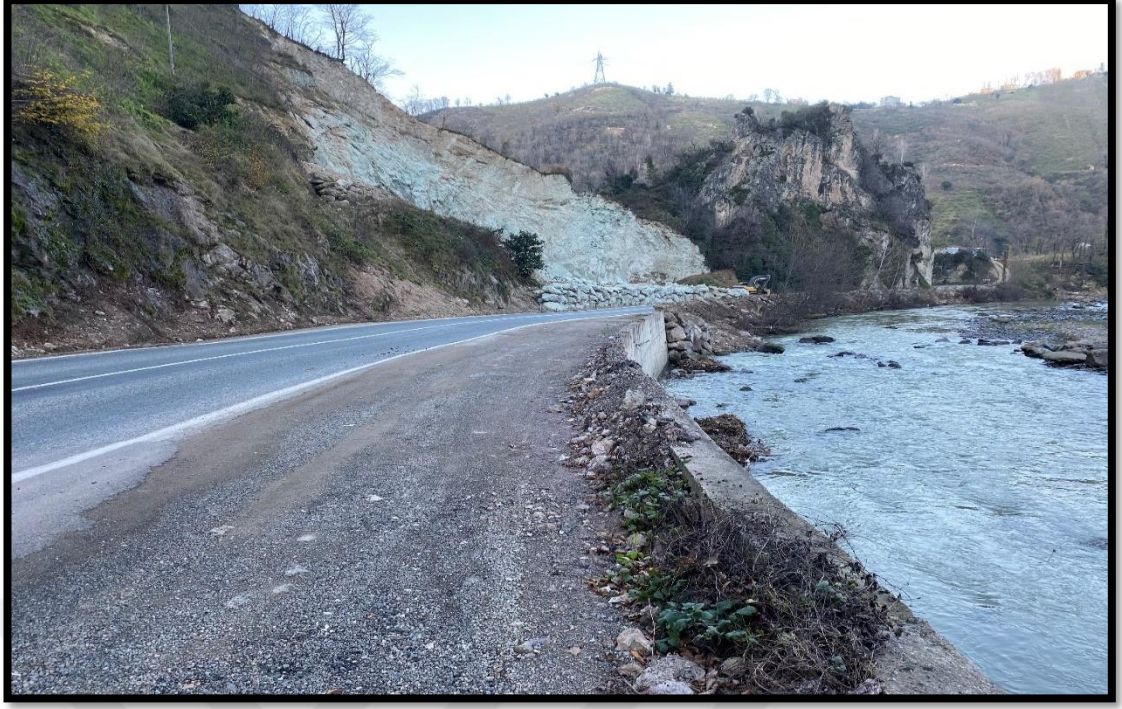
Şekil 5. 9 Yıldız Köyü'nün doğusunda, akarsuyun batı yamacında bulunan kazı çalışması ve yol genişletme çalışmaları(30.12.2022).
