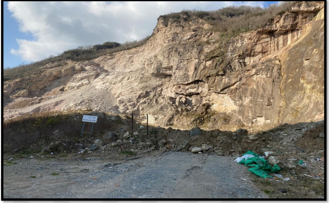
Şekil 5. 5 Şeyhmusa Köyü'nün güneydoğusunda yer alan taş ocağı (26.01.2023).
