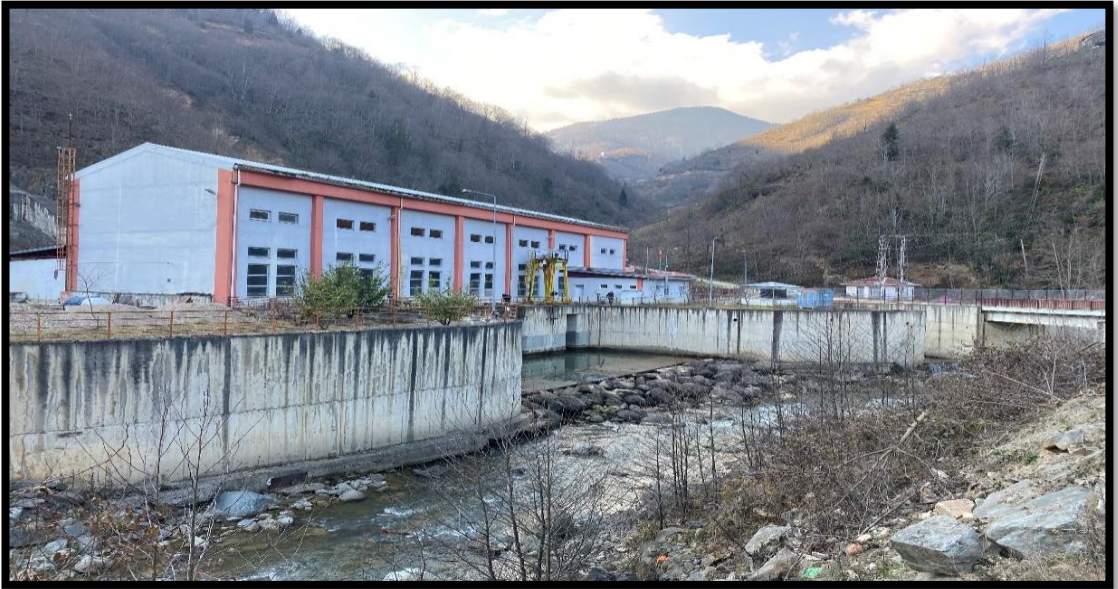
Şekil 5. 14 Torçan Köyü'nün güneydoğusunda Gültepe Köyü'nün kuzeydoğusunda bulunan HES (26.01.2023).
