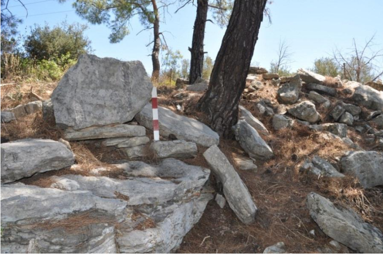
1.PDST44 Teras duvarı
