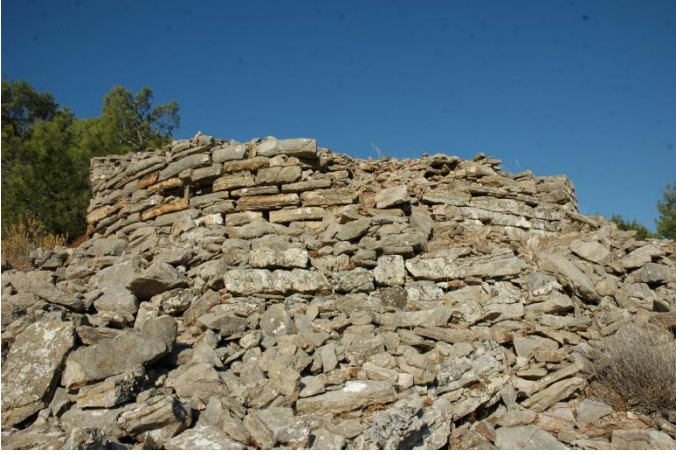
1.PDST23 Teras duvarı
