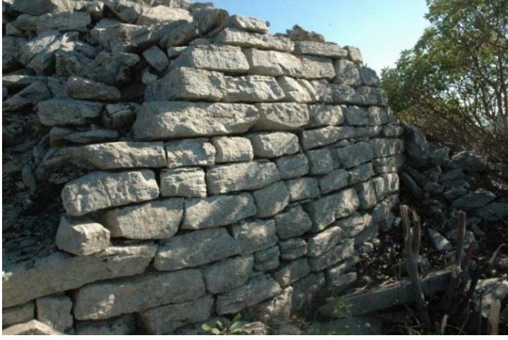
1.Kaplandağ, Tümülüs krepis duvarı
