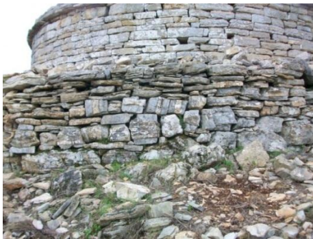
3.PDST19 Teras duvarı
