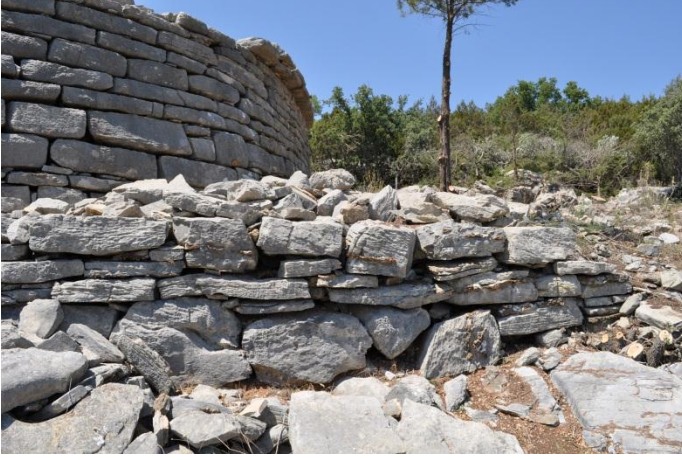
1. PDST7 Teras duvarı
