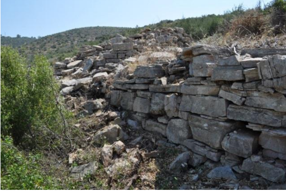
1. PDST74 Teras duvarı
