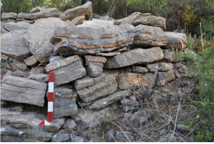
1.PDST4 Teras duvarı
