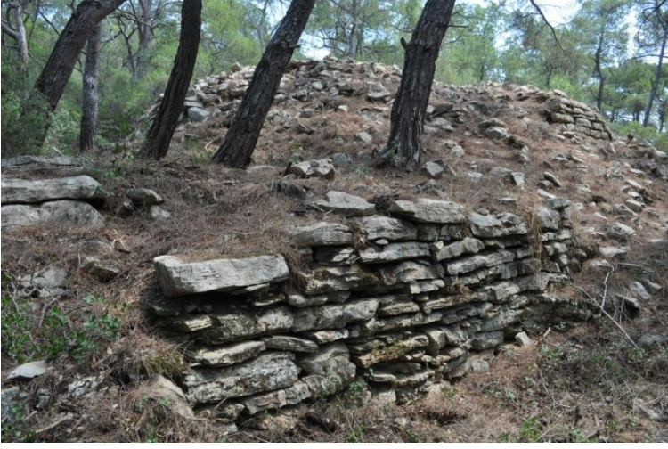
1. PDST33 Teras duvarı
