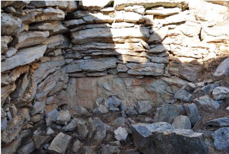
3.PDST39 Batı duvarı
