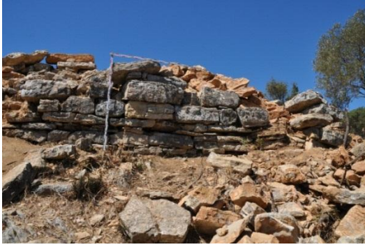
3.PDST1 Teras duvarı
