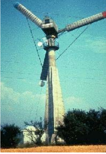
Resim 1.3. Gedser’de kurulan 200 kW’lık rüzgar türbini
