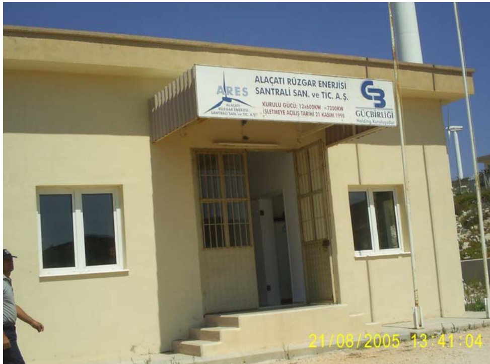
Resim 6.1. ARES şalt merkezinin ve personelin bulunduğu tek katlı bina
