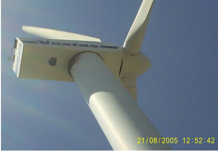
Resim 3.1. Türbinin kule üstündeki kafa kısmı-makine yatağı (Nacelle)
