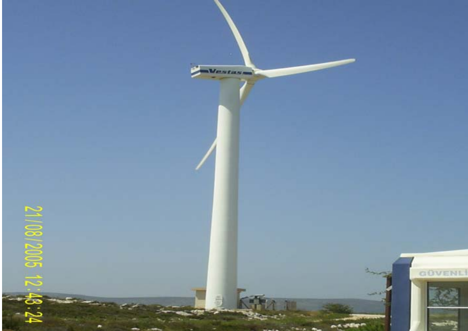
Resim 3.5. Konik boru şeklinde kule
