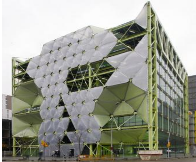
Şekil 3.12 : Media-TIC yapısının cephesi (Url-16).
