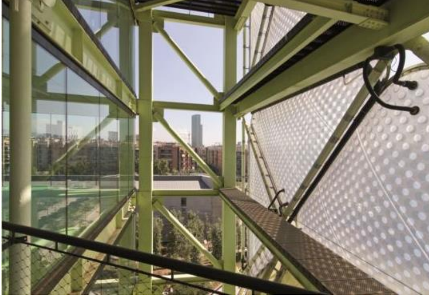
Şekil 3.15 : Media–TIC cephesinin hareketini sağlayan sistem (Url-18).
