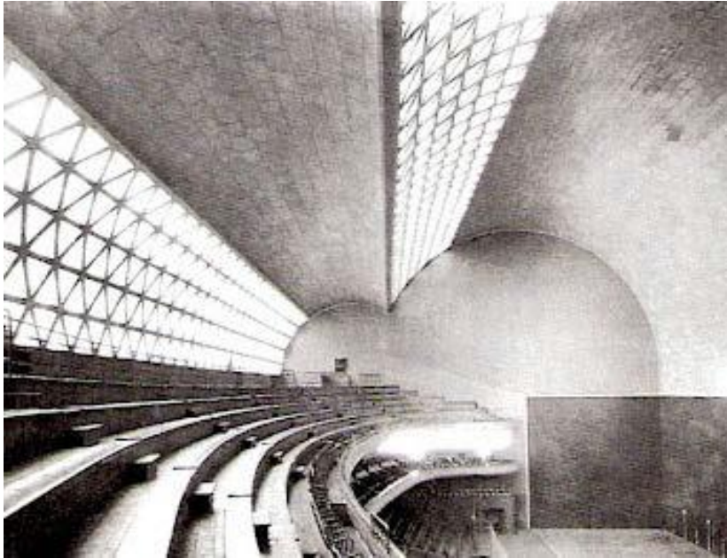
Şekil 2.5 : Betonarme kabuk, Frontón de Recoletos, Madrid,1935, (Url-3).
