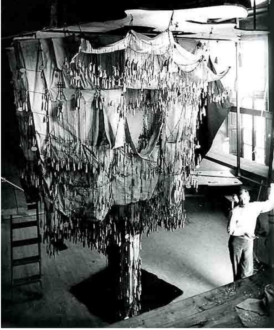
Şekil 2.4 : Colonia Güell için geliştirilen funiküler model ,Gaudí, 1889-1914 (Url-2).
