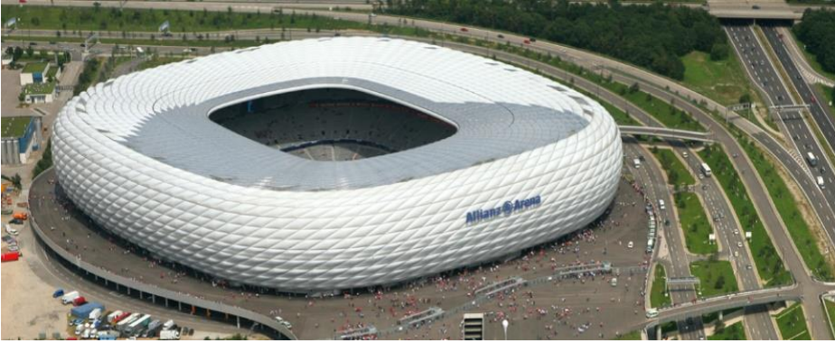
Şekil 4.16: Allianz Arena pnömatik bina kabuğu görüntüsü (Url-59)
