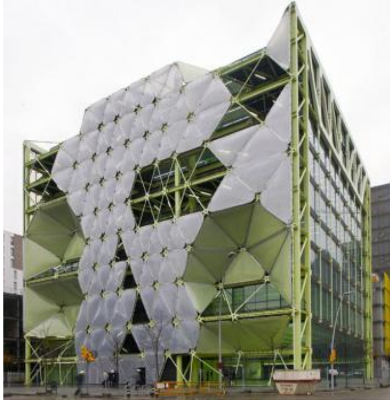
Şekil 2.16: Media–TIC cephesi kısmen açık halde iken (Url-17)
