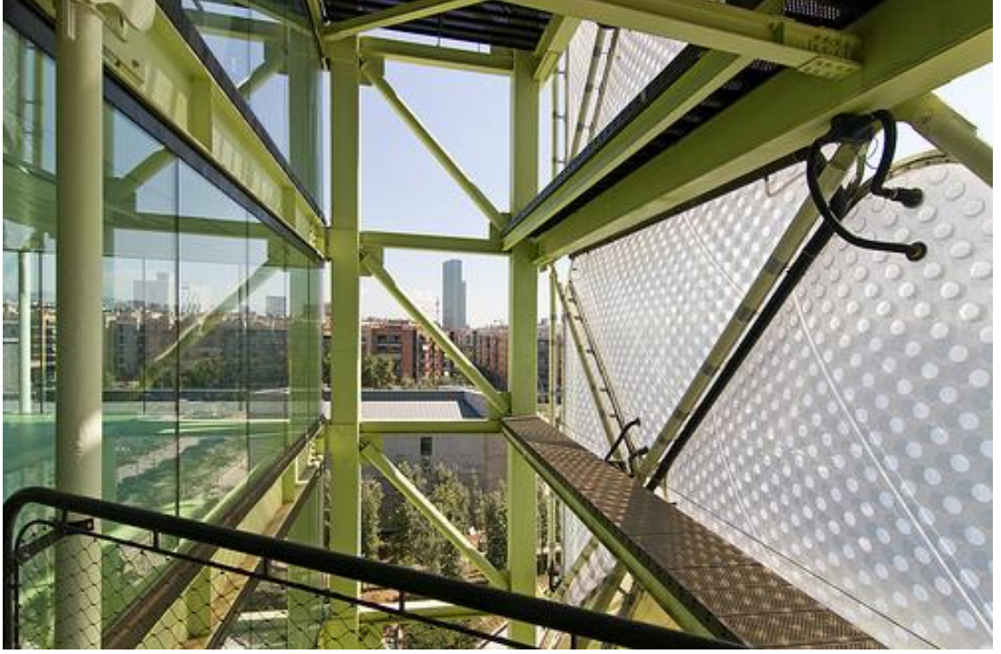
Şekil 2.19: Media–TIC cephesi hareketi sağlayan sistem (Url-20)
