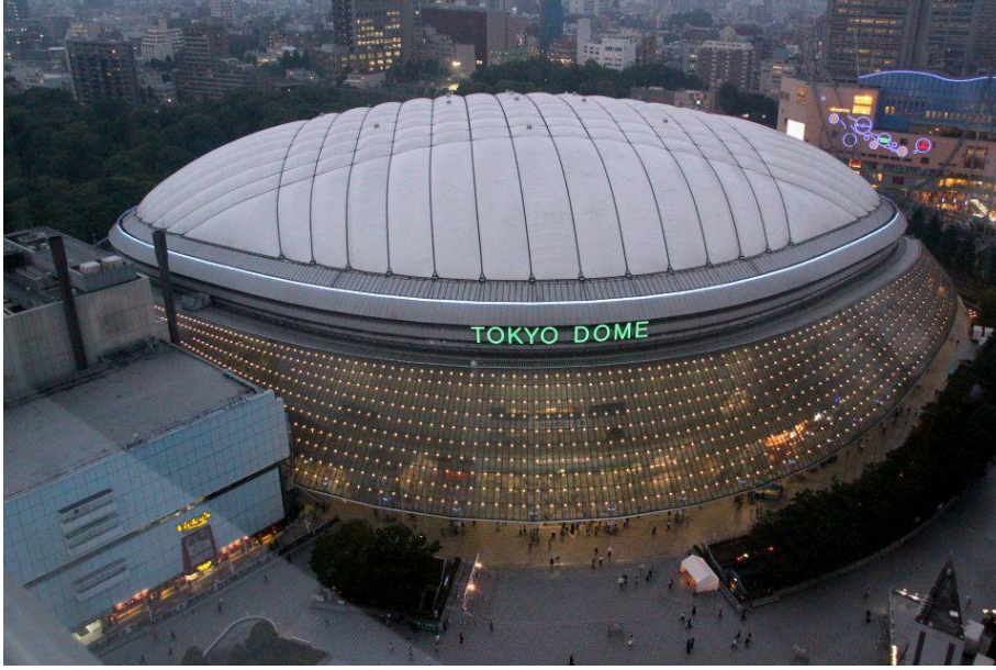
Şekil 4.11: Tokyo Dome Pnömatik çatısı (Url-54)
