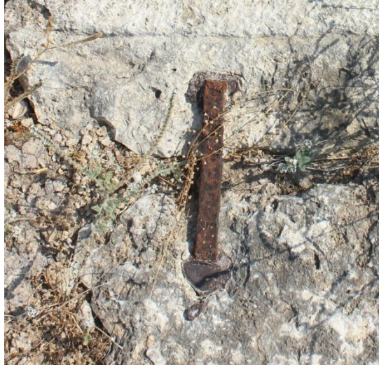
Resim 57: Doğu Duvardaki Metal Kenet
