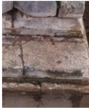
Resim 42: Stylobat Üzerindeki Kenet Deliği
