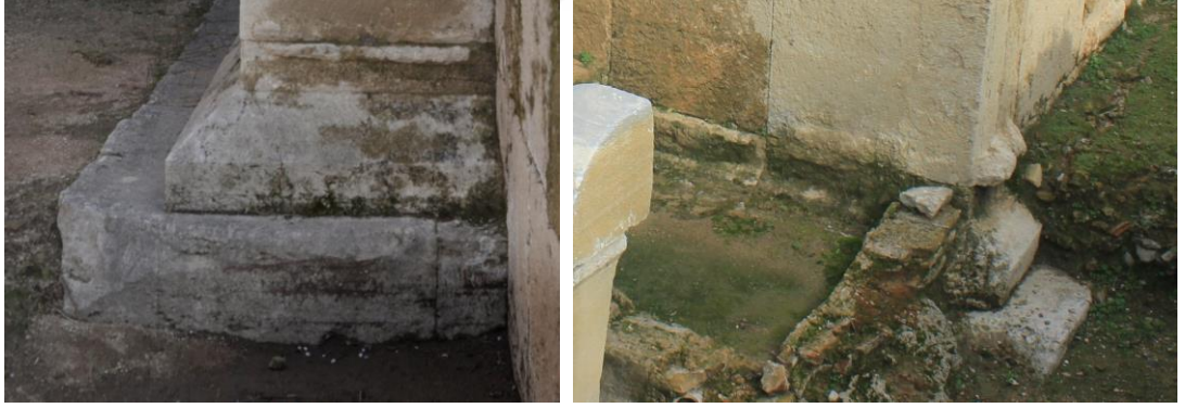
Resim 19: Podyumun Üzerine Oturduğu Stereobate Basamağı
