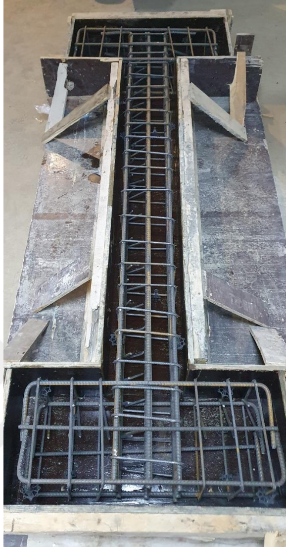
Şekil 4.15. Betonarme kolonların dökümü yapılacağı kalıp sistemi
