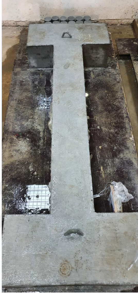
Şekil 4.18. Prizini almış betonarme kolonun kürleme işlemi
