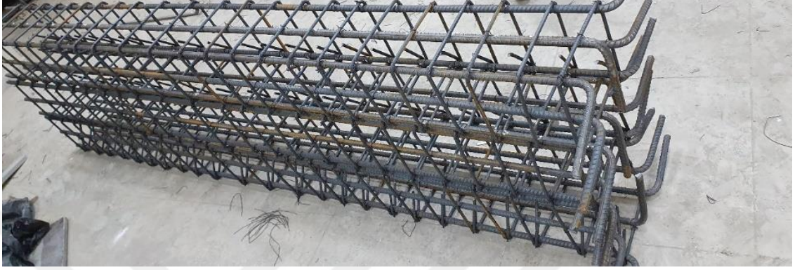
Şekil 4.14. Kolon numunelerde kullanılan etriyeleri bağlanmış boyuna donatılar
