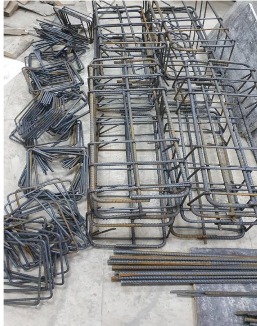
Şekil 4.13. Kolon numunelerde kullanılmış donatı kafesleri
