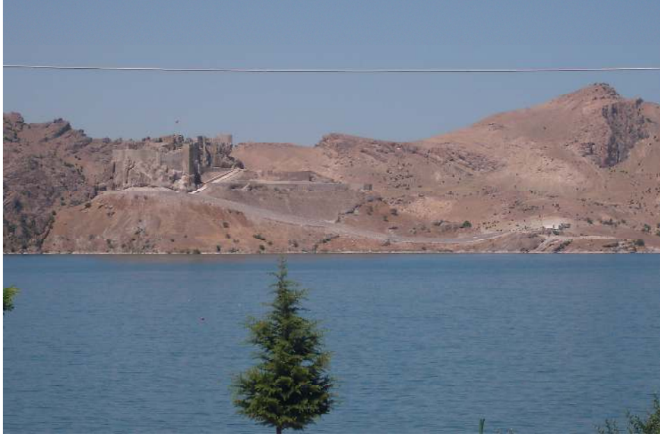
Fotoğraf 7: Restorasyondan Sonra Pertek Kalesinin Son Görünüşü
