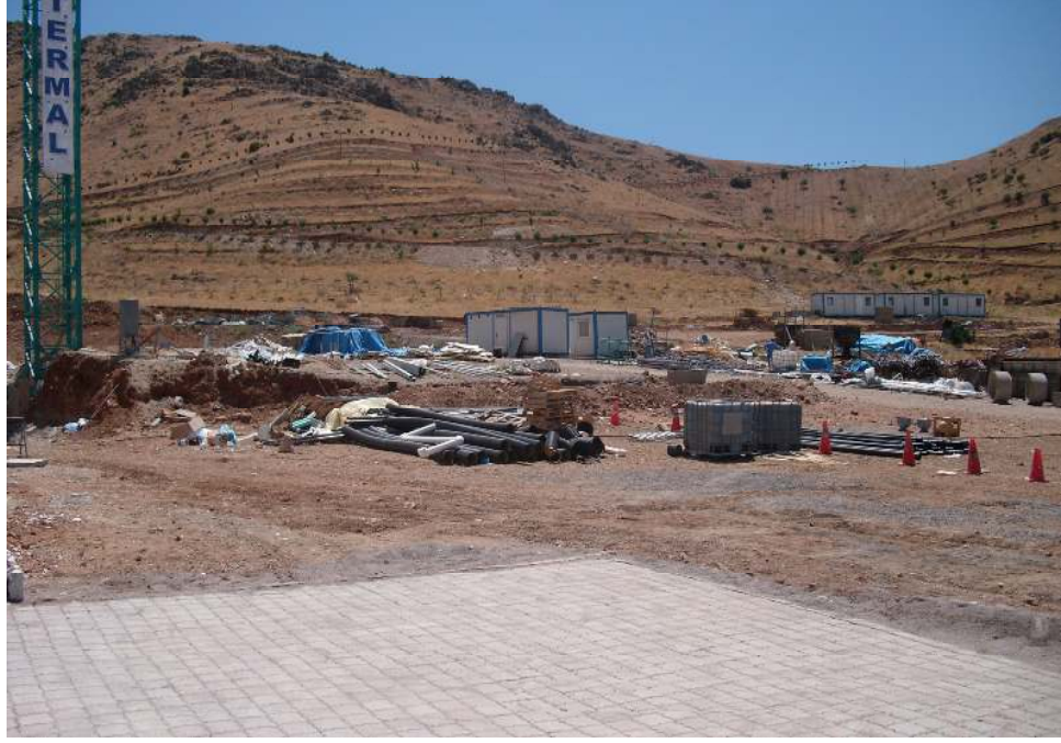
Fotoğraf 14: Termal Tesisin Otel Kısımının İnşa Edileceği Alan
