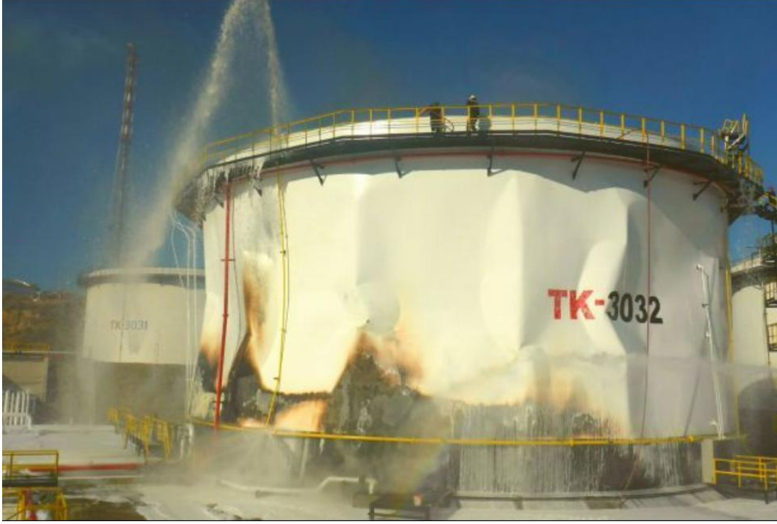
Resim 26. Tüpraş İzmir Rafinerisi Patlama Sonrası TK-3032
