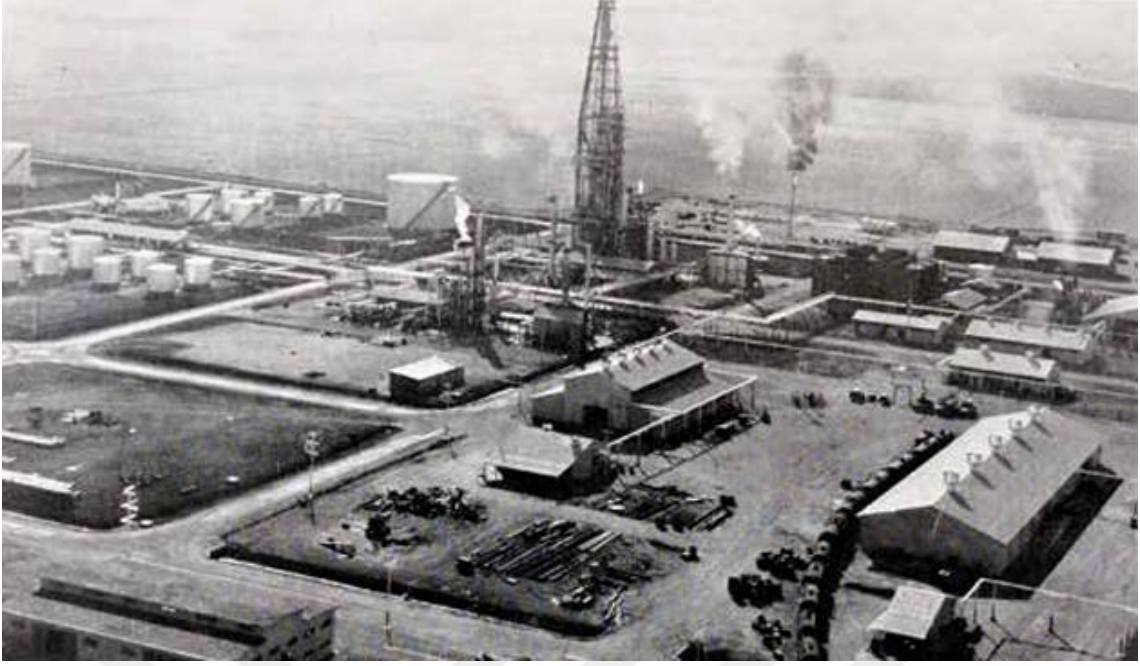
Resim 2. Batman Rafinerisi ham petrol işleme tesislerinden görünüş
