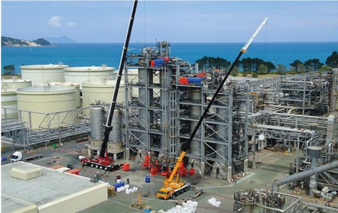
Resim 7. Katalizörün Reaktörlere Yüklenmesi
