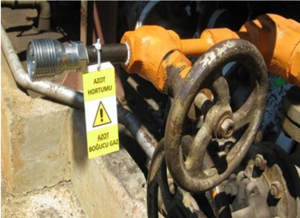
Resim 11. Tek Taraflı Dişi Quick Kaplin Azot Hattı
