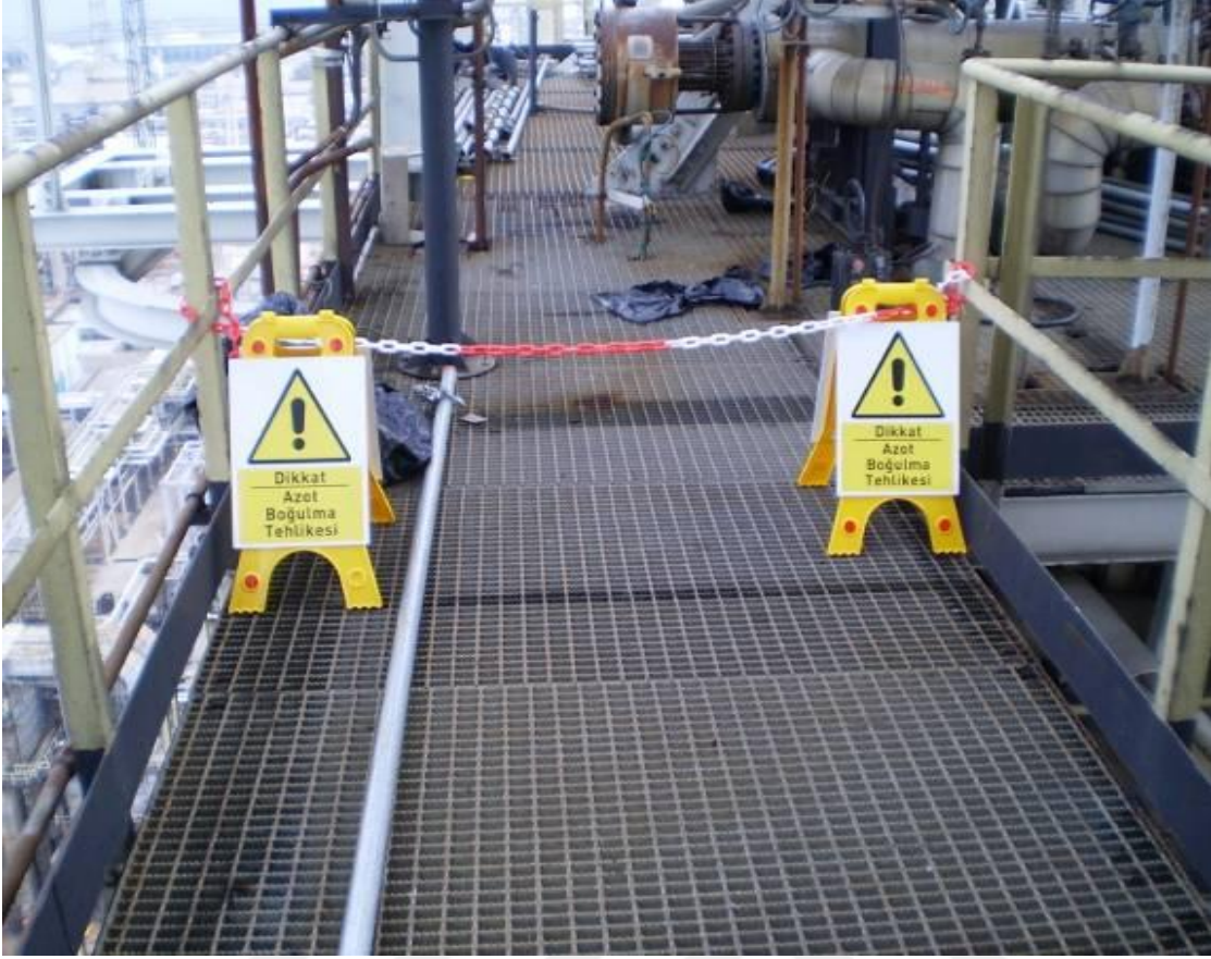
Resim 8. Çalışma Alanında Azot Uyarı Levhaları
