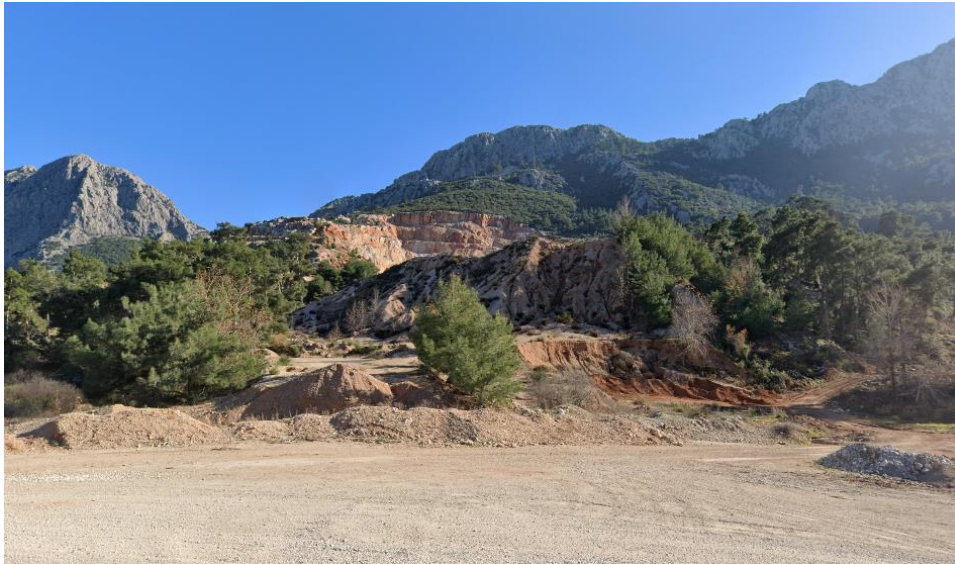
Şekil 4.2. Çakırlar mahallesi taş ocağı kırma ve eleme tesisi
