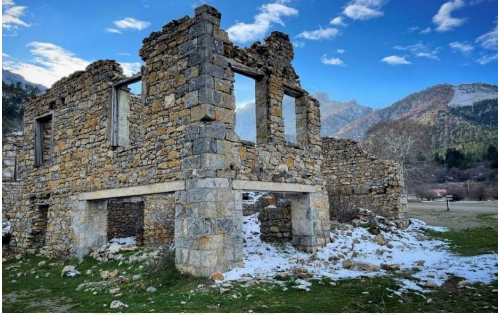
Şekil 4.14. Beledik’te Bulunan Yapı Kalıntıları (Orijinal, 2020).
