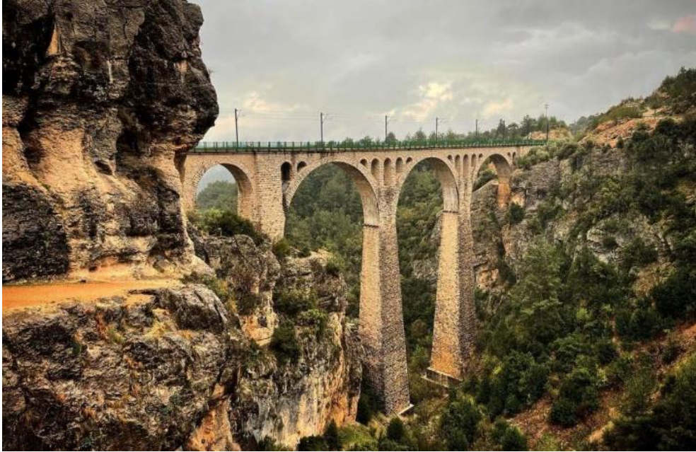
Şekil 4.12. Alman Köprüsü (Orijinal, 2021).
