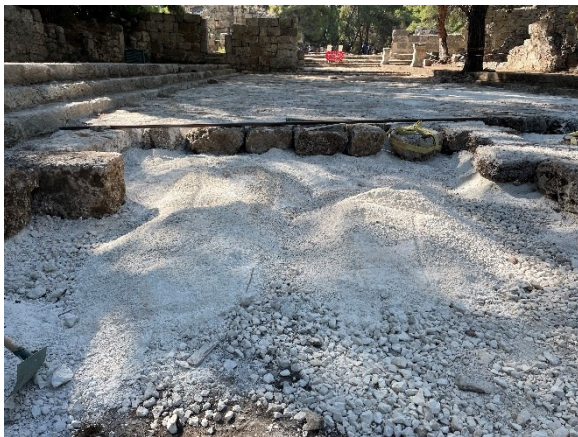
Fotoğraf 2.45. Cadde Zeminine Blokaj Serildikten Sonrası (Kaynak: Akçay, 2023).
