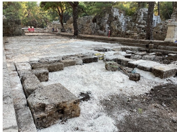
Fotoğraf 2.56. Cadde Zeminine Blok Yerleştirme İşlemi Sonrası (Kaynak: Akçay,2023).
