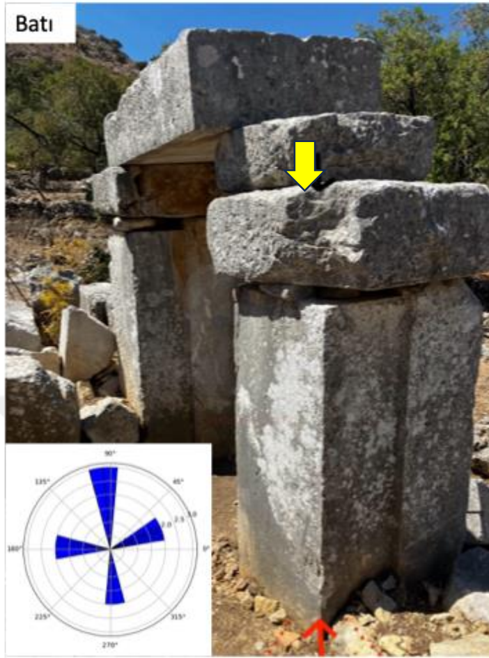
Şekil 3.2. Phoenix Antik Kenti'nin batı tarafında yer alan kilise tapınak kapısındaki çatlak (kırmızı ok) ve kırık köşe (sarı ok), pusula yardımıyla ölçülen deformasyon yönelim açılarına göre QGIS 3.36 programı üzerinde oluşturulan gül diyagramı ile görselleştirilmiştir
