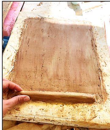
Şekil 31- Stroter kalıbına sıvanan çamurun, tamamen kalıbı doldurduktan sonra damlalık kısmının eklenmesi (Fotoğraf: M. Aslı Gördes)
