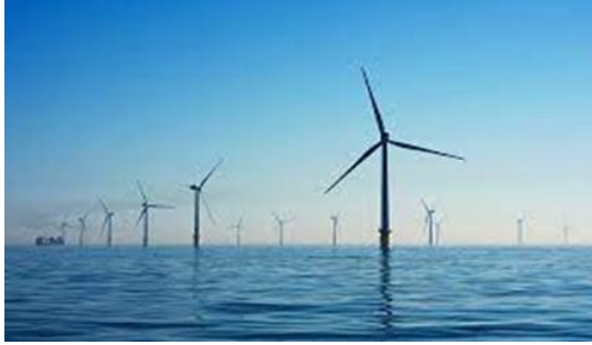
Şekil 2.4 Açık deniz rüzgâr türbinleri
