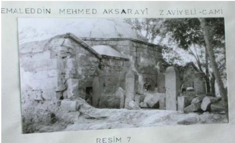
Resim 3.92. Cemaleddin Mehmed Aksarayi Zaviyesi'nin yıkılmadan önceki fotoğrafı kuzey cephe, 1970'li yıllar (Konya Vakıflar Bölge Müdürlüğü Arşivi'nden)
