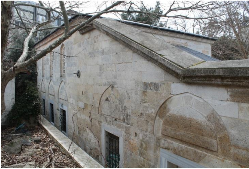
Resim 3.25. Silivri Pîrî Mehmed Paşa Sıbyan Mektebi, doğu cephe
