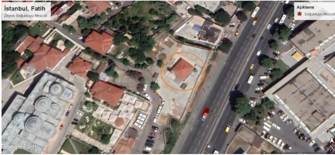
Resim 3.66. Pîrî Mehmed Paşa (Soğukkuyu) Mescidi uydu fotoğrafı ( https://earth.google.com , 22.11.2021)
