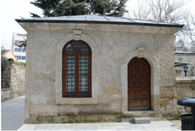
Resim 3.29. Silivri Pîrî Mehmed Paşa muvakkithane, batı cephesi
