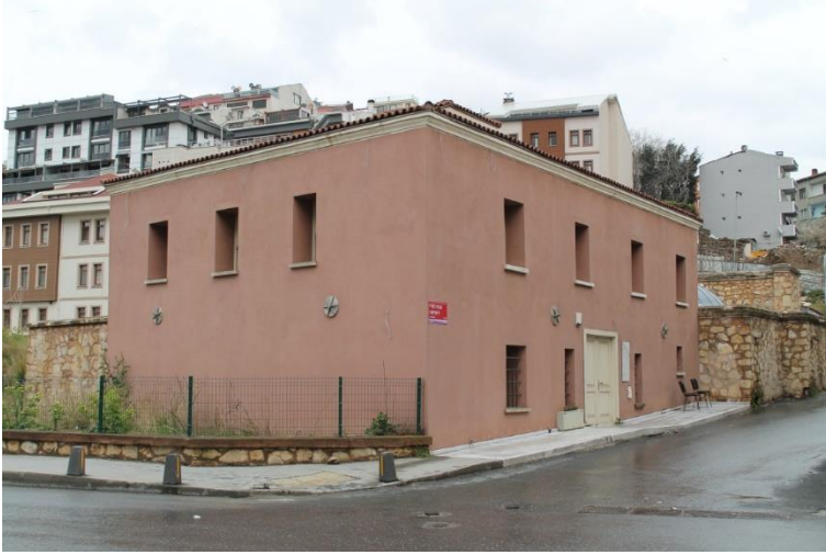
Resim 3.100. Pîrî Mehmed Paşa Hamamı, güneybatıdan bakış
