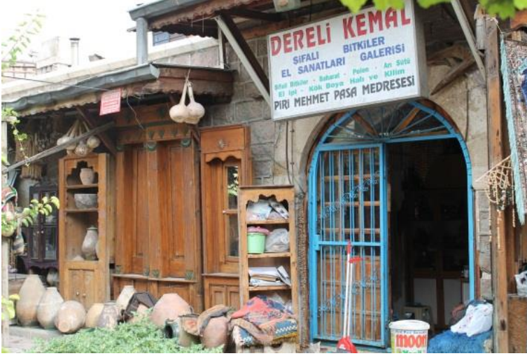
Resim 3.61. Pîrî Mehmed Paşa Zaviyesi, güney cephe kapısı
