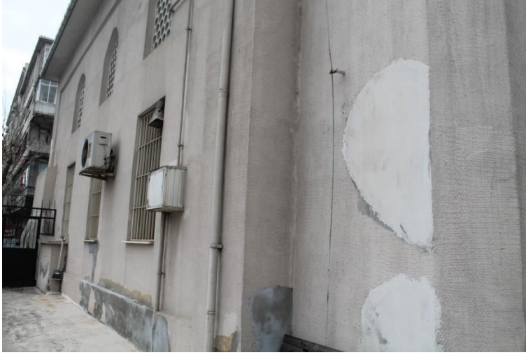
Resim 3.77. Pîrî Mehmed Paşa Camisi, güneydoğu cephe
