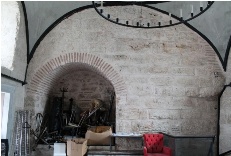
Resim 3.115. Pîrî Mehmed Paşa Mektebi, doğu duvar
