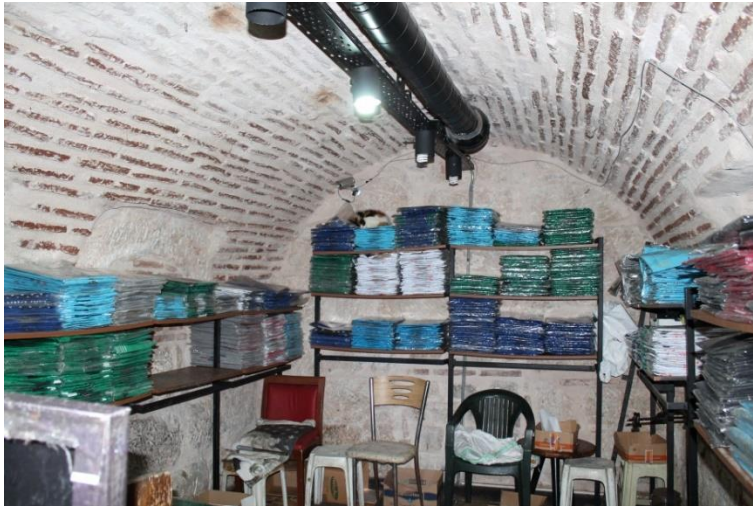
Resim 3.112. Pîrî Mehmed Paşa Mektebi, alt kat güneydeki mekân
