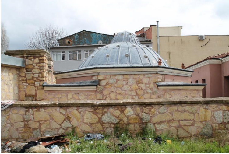
Resim 3.99. Pîrî Mehmed Paşa Hamamı, kuzey cephe sıcaklık bölümü
