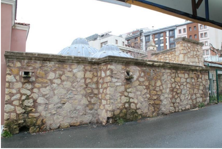
Resim 3.101. Pîrî Mehmed Paşa Hamamı güney cephe avlu duvarından sıcaklık bölümüne bakış
