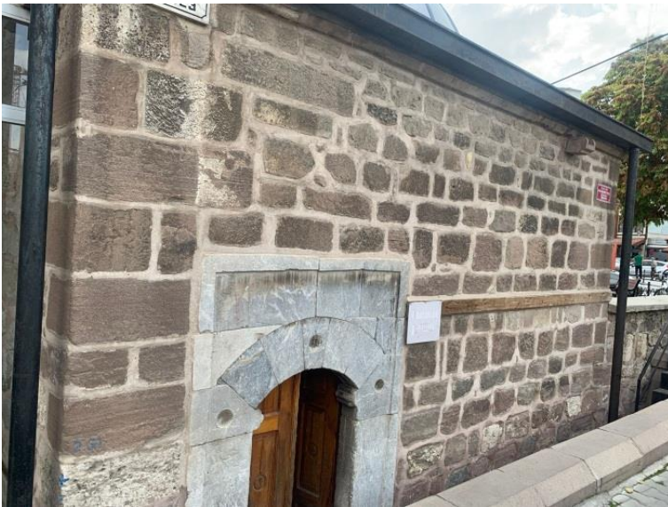
Resim 3.51. Pîrî Mehmed Paşa mutfak, kuzey cephe
