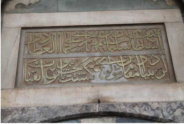
Resim 3.42. Konya Pîrî Mehmed Paşa Camisi, giriş kapısı üzerindeki kitabe
