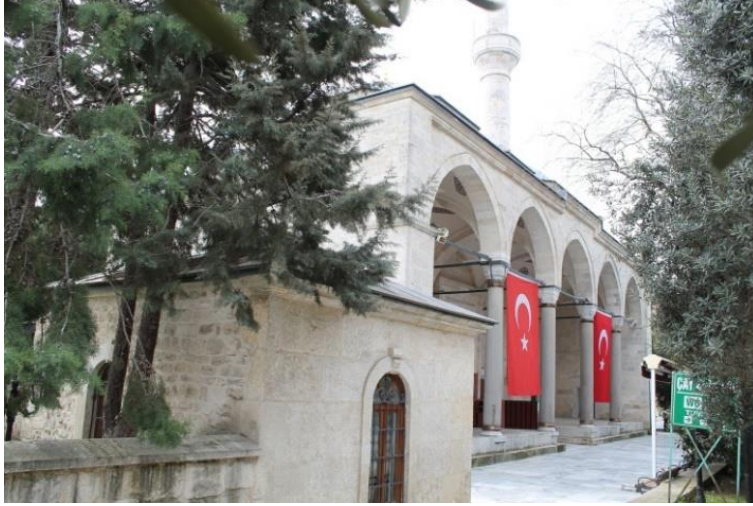
Resim 3.7. Silivri Pîrî Mehmed Paşa Camisi, kuzey cephe
