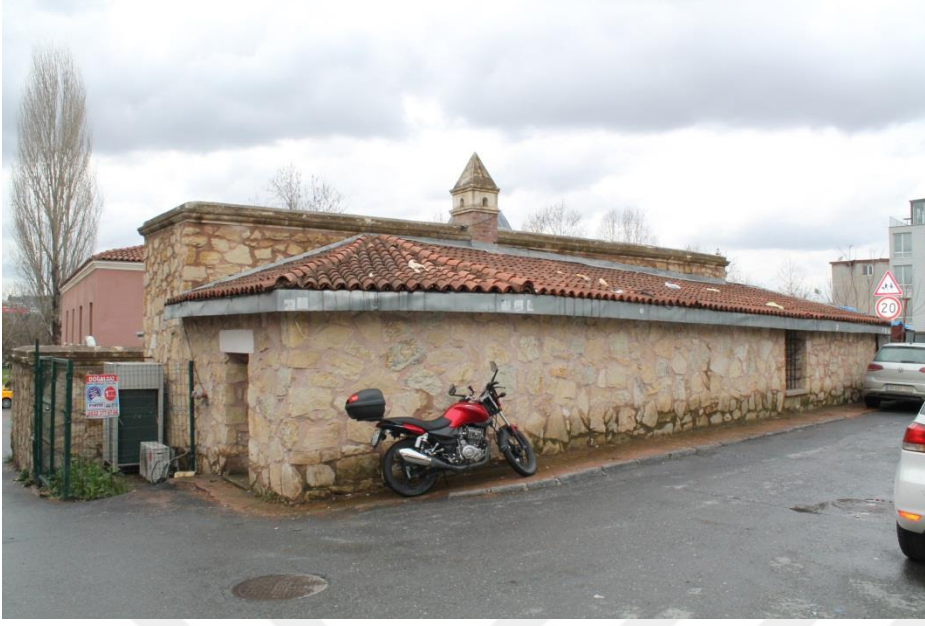
Resim 3.97. Pirî Mehmed Paşa Hamamı, doğu cephe
