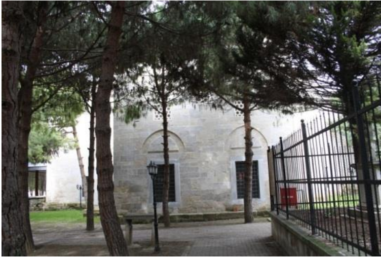
Resim 3.5. Silivri Pîrî Mehmed Paşa Camisi, güney cephesi
