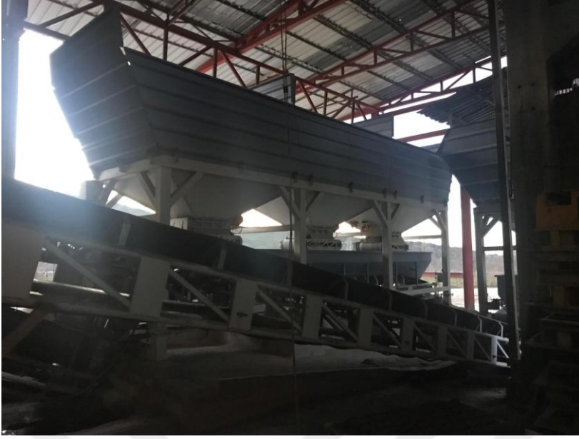
Şekil 2. Parke üretim tesisinde agrega haznelerinin görüntüsü
