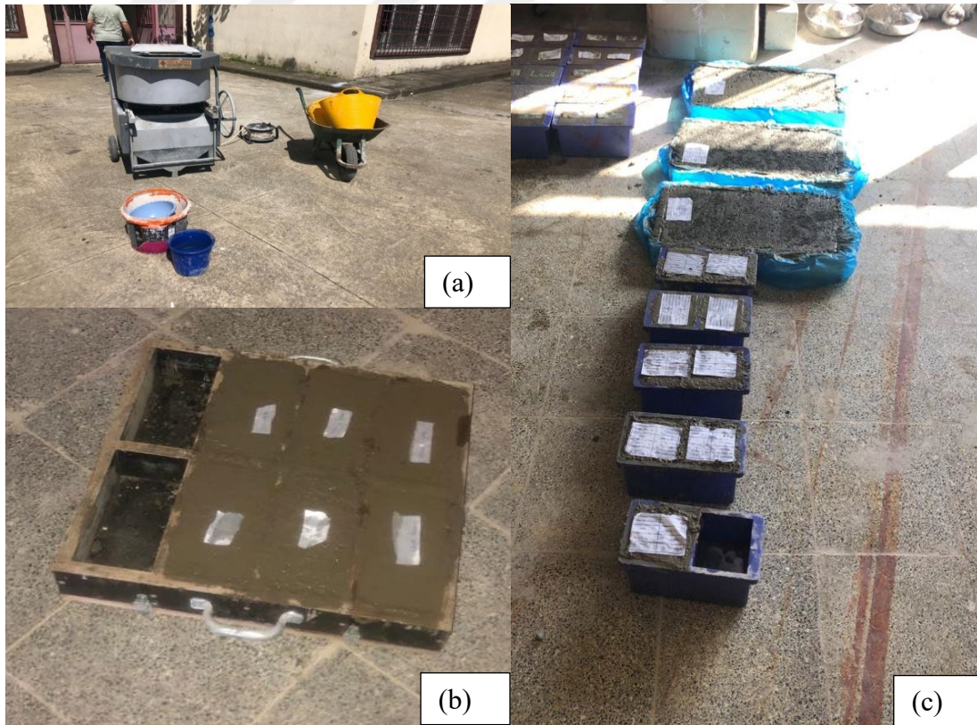
Şekil 13. Beton Karıştırıcı ve Numune Kalıplarına Yerleştirilen Beton
