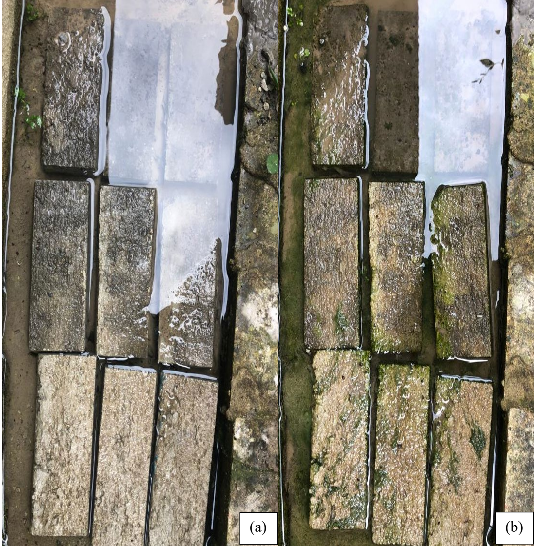
Şekil 24. 50x240x500 mm Numunelerden Kesilerek Elde Edilen 50x80x200 Ebatlarındaki Numunelerin Kirlı Su Kanaldaki a) İlk Gn Grnts b) 2 Ay Sonraki Grnts
