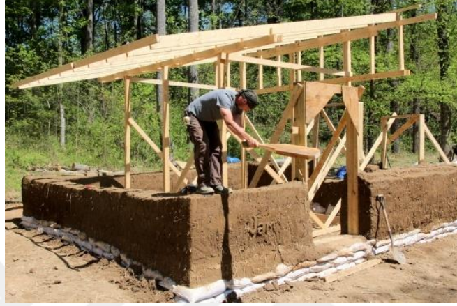
Fotoğraf 9: El ile serbest şekillendirilen ve yığma çamur ile yapılan bir inşaat ( Cob Home, Web)
