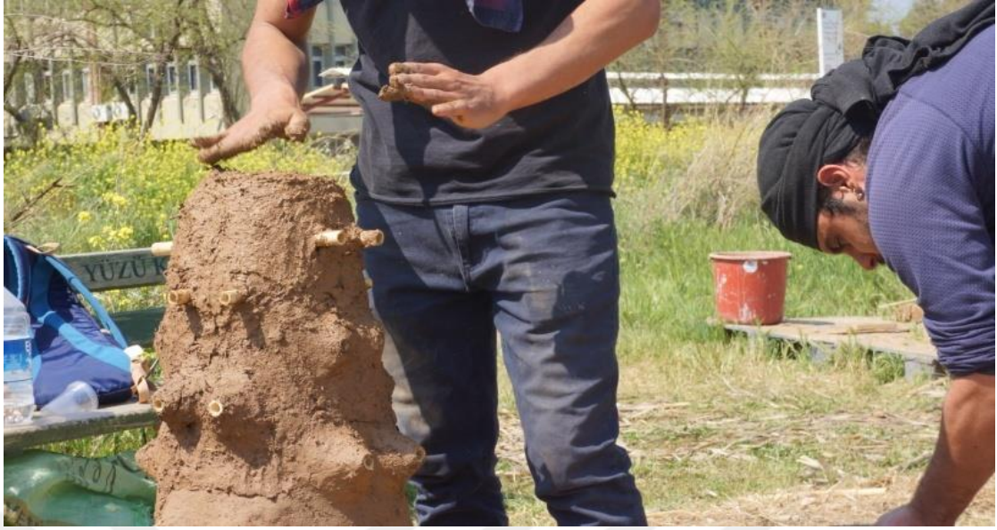
Fotoğraf 128: İnşa sürecinden bir görünüm
