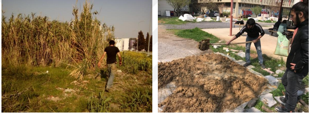
Fotoğraf 117: Sazlık kamışlarının elde edilmesi ve dinlendirilen kerpiç çamurunun karılması işlemi
