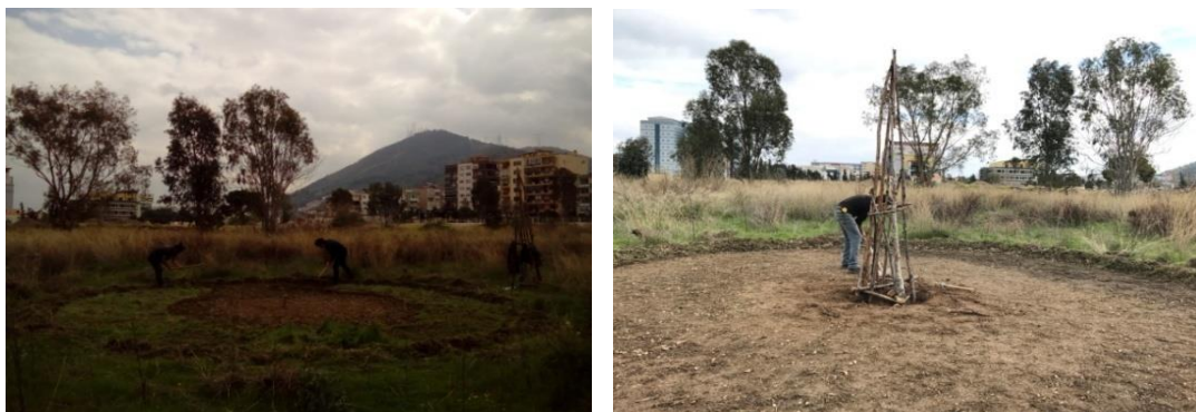
Fotoğraf 116: İnşanın yapılacağı yerin açılması ve strüktürün yerleştirilme işlemi
