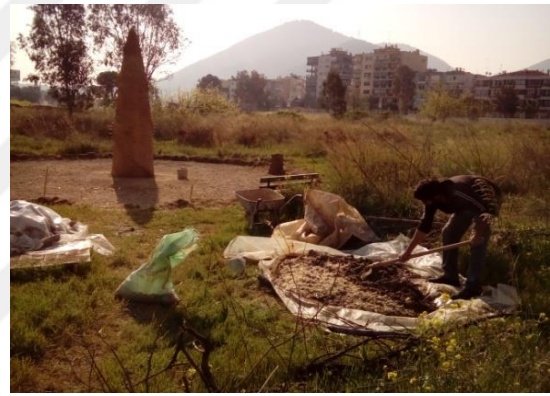
Fotoğraf 124: On iki adet kerpiç formun inşası için toprak çıkarılması ve bu toprağın harç haline getirilişi
