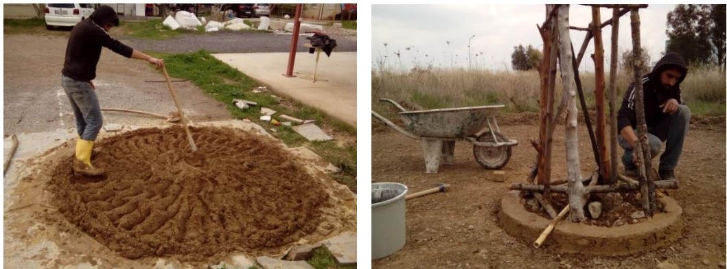
Fotoğraf 118: Dinlendirilen kerpiç çamurunun çiğnenmesi ve yapı temelinin hazırlanışı
