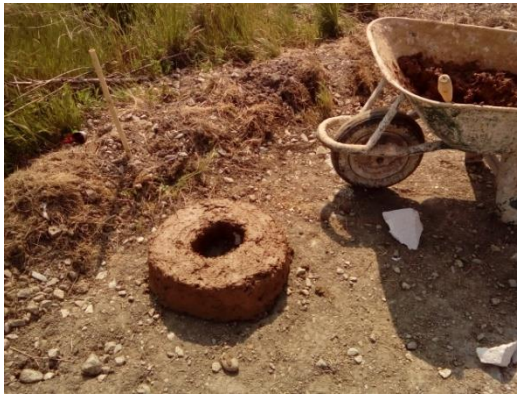
Fotoğraf 125: Kerpiç formun temel hazırlığı ve inşa için üretilen tuğlalar
