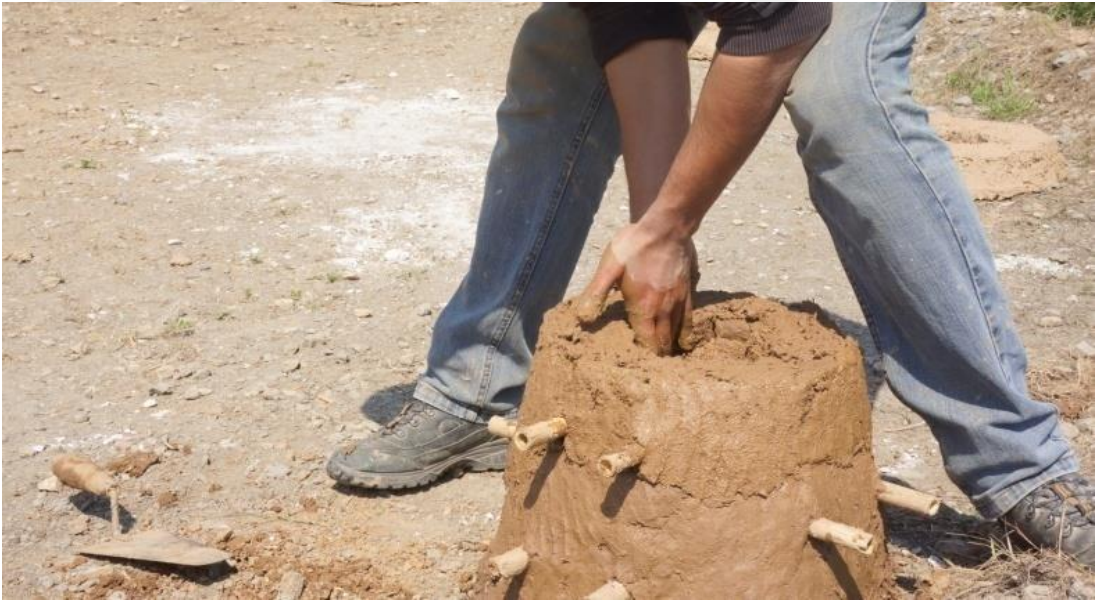
Fotoğraf 131: İnşa sürecinden bir görünüm
