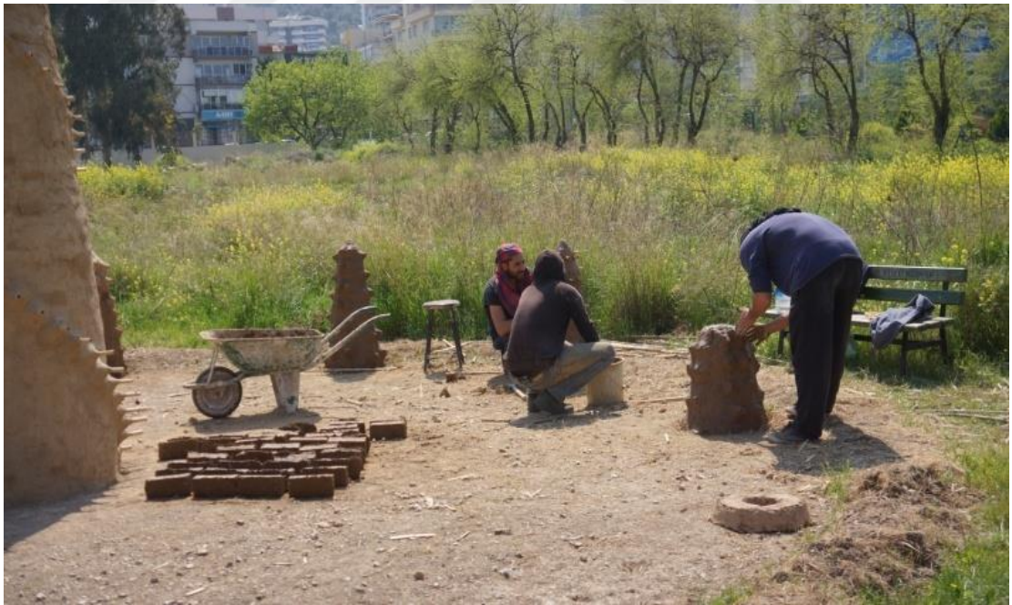
Fotoğraf 129: İnşa sürecinden bir görünüm
