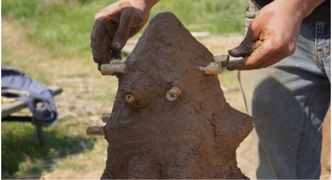
Fotoğraf 133: İnşa sürecinden bir görünüm
