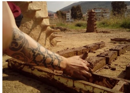
Fotoğraf 125: Kerpiç formun temel hazırlığı ve inşa için üretilen tuğlalar
