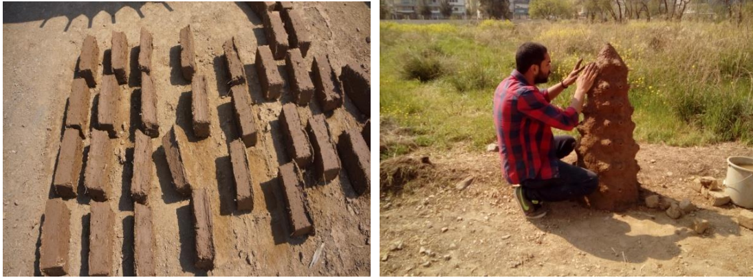
Fotoğraf 126: Üretilen kerpiç tuğlaların kuruma aşaması ve formların inşa süreci
