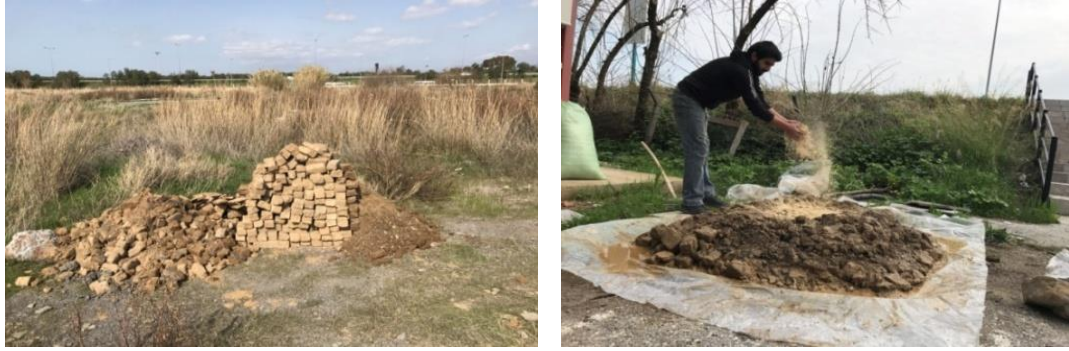
Fotoğraf 115: Enkazdan elde edilen sağlam kerpiç tuğlalar ve ufalanan tuğla parçalarının dönüştürülme işlemi
