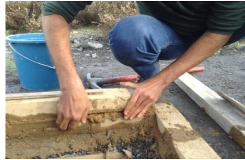
Fotoğraf 7: Tuğlaların balçık harç ile örülmesi
