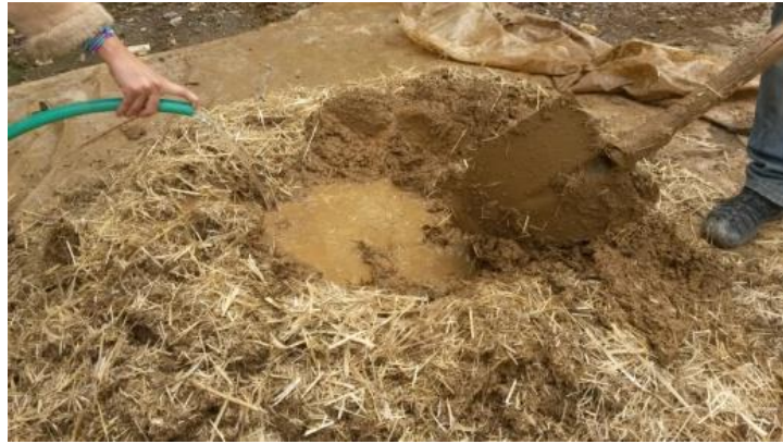
Fotoğraf 3: Saman ve su katılmış toprağın çamur haline getirilişi
