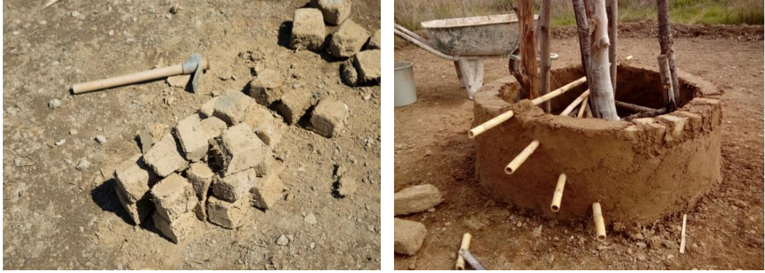
Fotoğraf 119: Kerpiç tuğlaların keser ile küp şeklinde kesilmesi ve daire duvarın örülmeye başlanması
