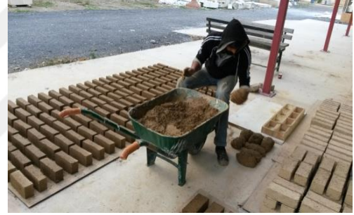
Fotoğraf 5: Kerpiç tuğla üretiminde kullanılan ahşap kalıplar ve basılacak çamur toprakların hazırlanması
