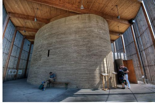
Fotoğraf 91 : Mabedin sıkıştırılmış toprak ile yapılmış ana bölümü, Berlin
