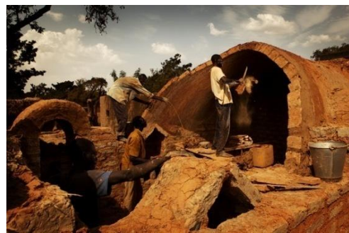
Fotoğraf 84 : La Voûte Nubienne adlı dernek tarafından yapılan tonozlu bir yapının inşa aşaması, Burkina Faso
