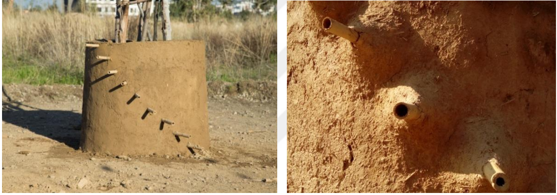
Fotoğraf 120: Yükseltilmeye başlanan daire duvardaki sarmal kamış dizilimi ve hacim kazandırılmış yapı yüzeyi
