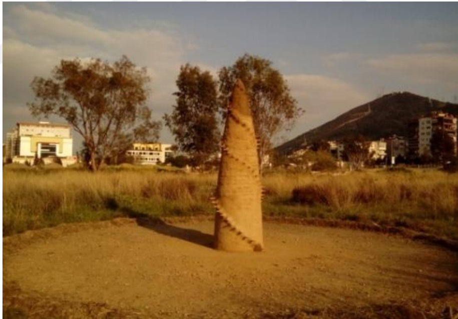
Fotoğraf 123: Merkezdeki yapının kurumaya bırakılması
