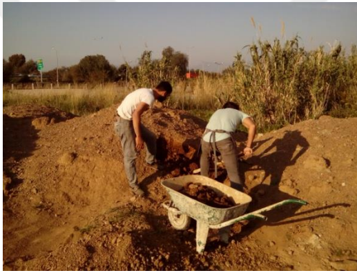
Fotoğraf 124: On iki adet kerpiç formun inşası için toprak çıkarılması ve bu toprağın harç haline getirilişi
