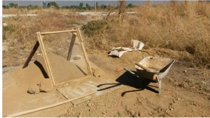
Fotoğraf 1: Elek ile toprağı kerpiç yapımına hazır hale getirme
