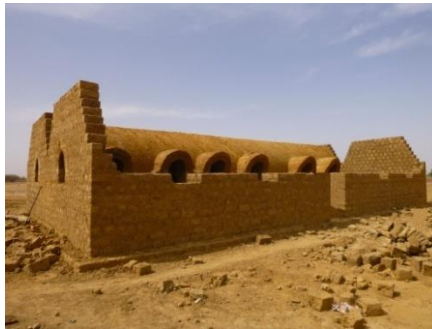
Fotoğraf 84 : La Voûte Nubienne adlı dernek tarafından yapılan tonozlu bir yapının inşa aşaması, Burkina Faso
