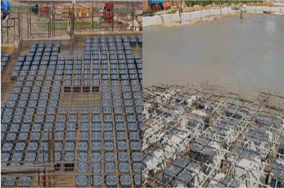
Şekil 3.15. Kör kalıp dizilimi ve beton dökümü
