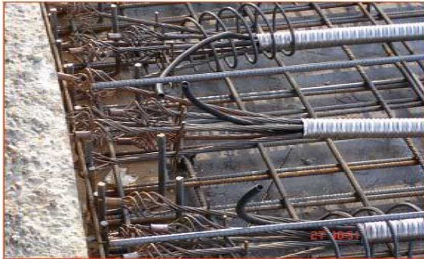
Şekil 3.10. Kör ankraj ile halatların kilitlenmesi
