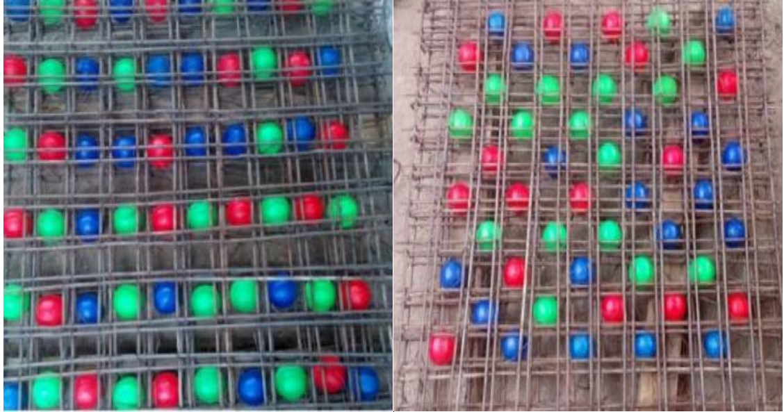
Şekil 1.2. Döşeme ağırlığının azaltılmasında kullanılan geri dönüşümlü plastik malzemeler
