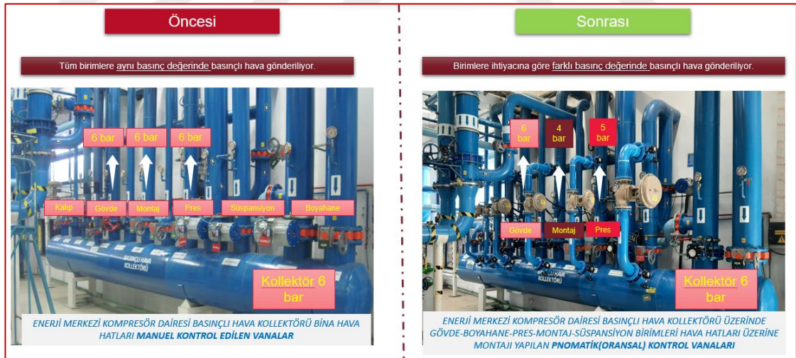
Şekil 4.13. Manual ve Oransal Vana Kullanımının sistem üzerindeki görünümü
