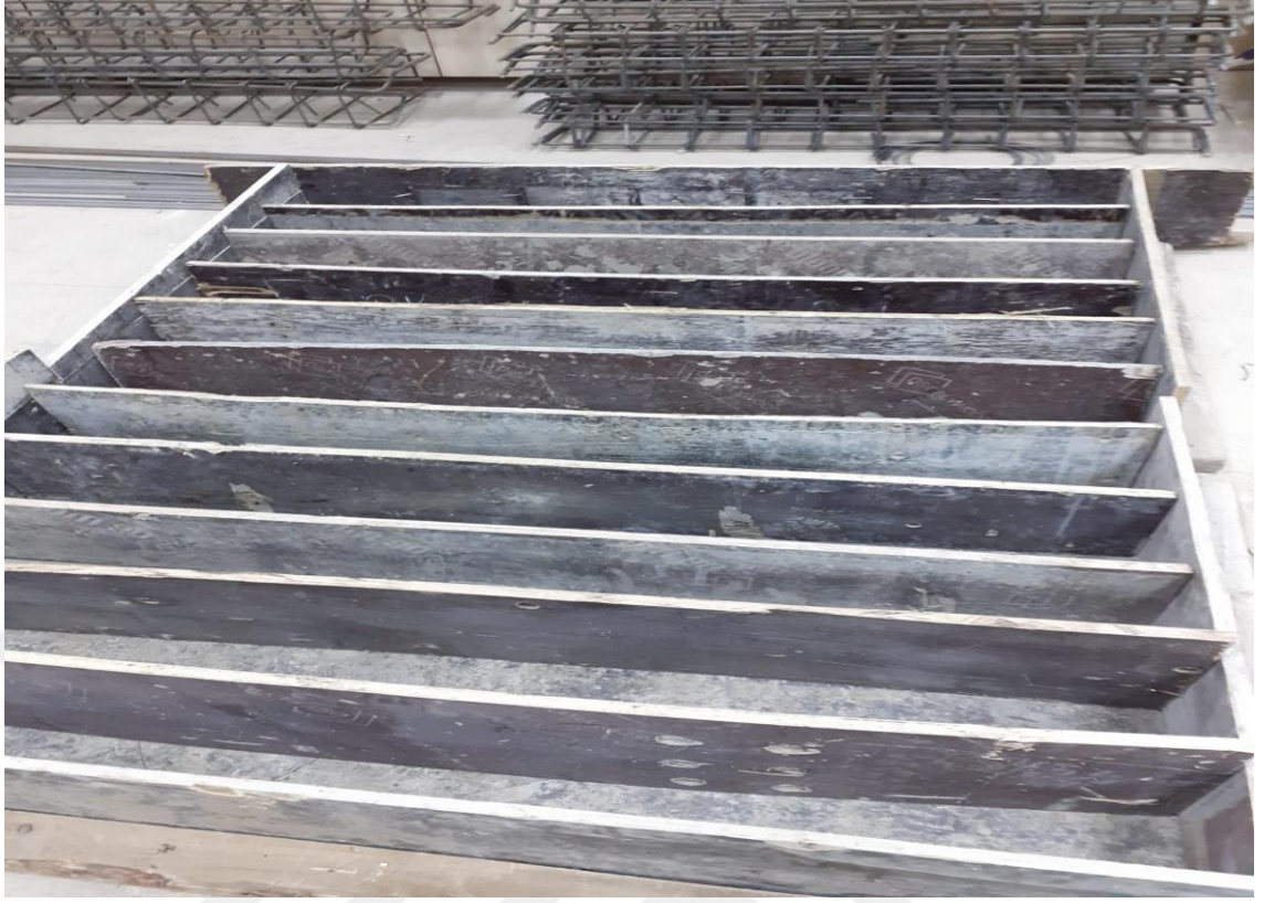
Şekil 3.3. Betonarme kiriş numunelerinin kalıp imalatı
